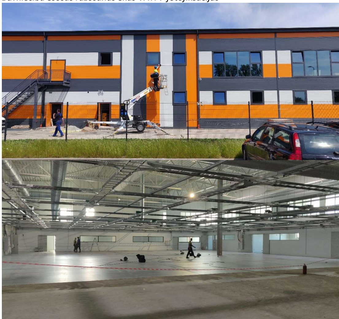
Būvniecībā esošās ražošanas ēkas VATP7 fotofiksācijas
