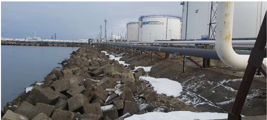
3.kārta - krasta nostiprinājuma atjaunošana posmā starp 2.muliņu un 1.muliņu.
