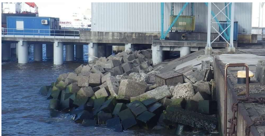
4.kārta - krasta nostiprinājuma atjaunošana posmā starp 1.muliņu un 27.piestātni.
