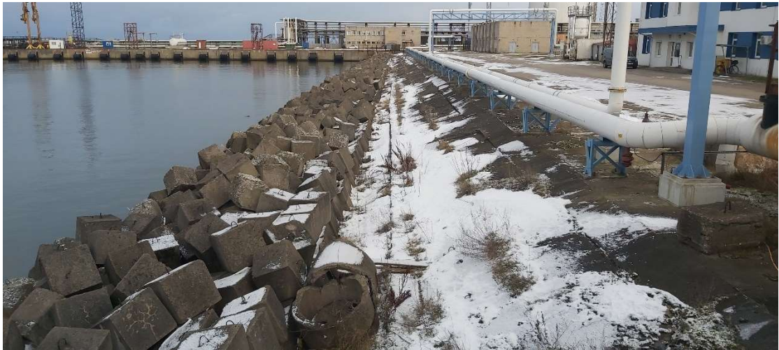
2. kārtā - krasta nostiprinājuma atjaunošana posmā starp 3.muliņu un 2.muliņu
