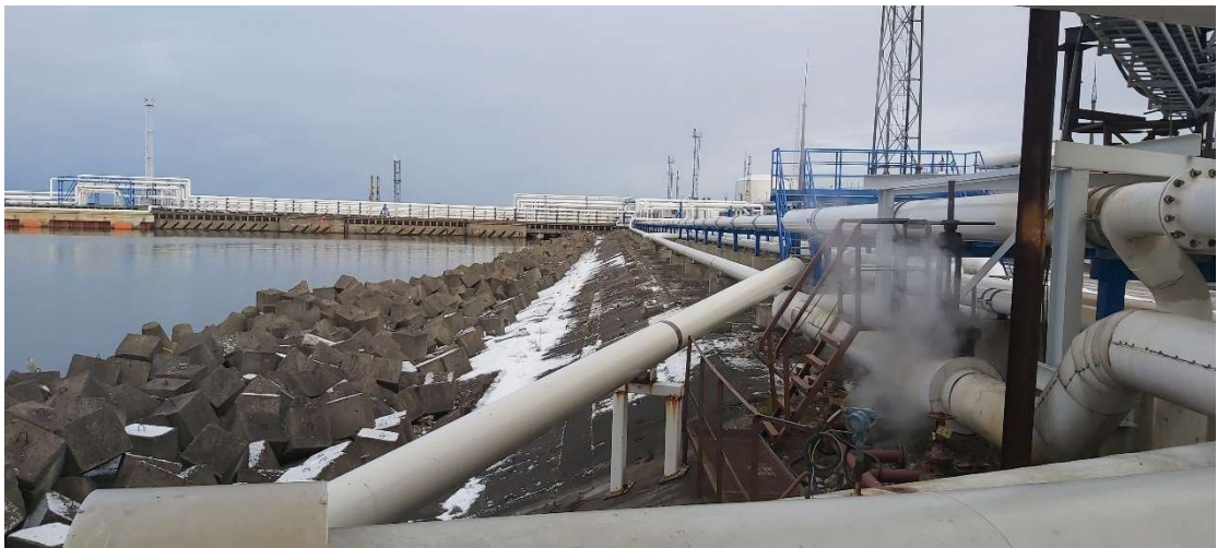
3.kārta - krasta nostiprinājuma atjaunošana posmā starp 2.muliņu un 1.muliņu.
