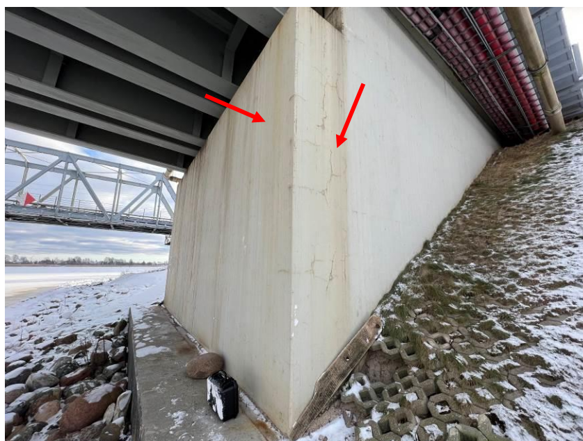
30.att. Notecējumi uz balsta ķermeņa, notiek ķīmiski procesi betonā – veidojas plaisu tīkls. Skats uz krasta balstu Nr.1 no lejtecēs.
