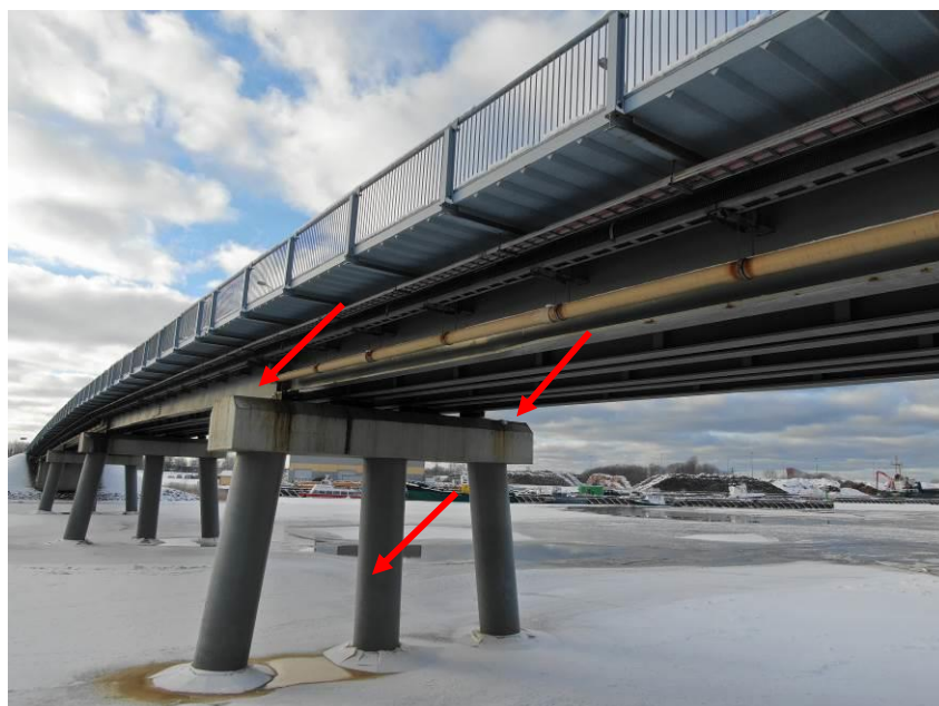
42.att. Notecējumi uz balsta uzkalas, notiek ķīmiski procesi betonā – veidojas plaisu tīkls. Lokāli krāsojuma bojājumi statiem. Skats uz upes balstu Nr.4 no Pārventas puses.
