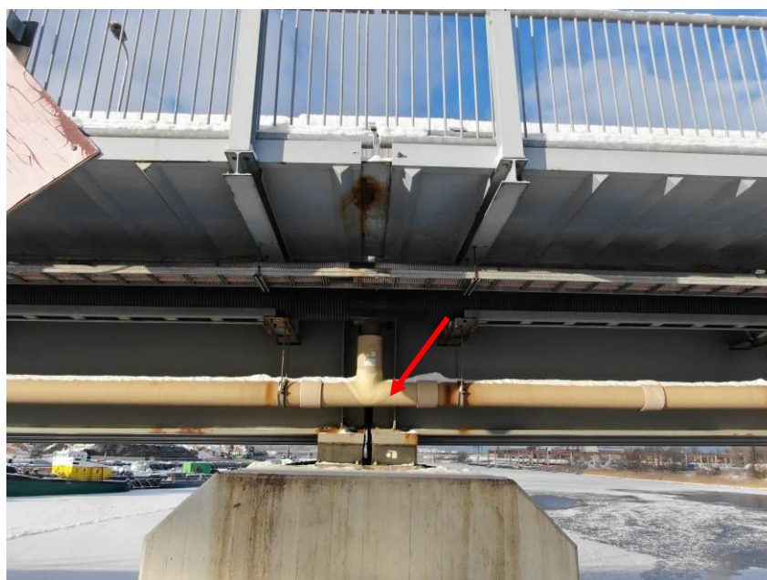
38.att. Brauktuves virsmas ūdens tek uz balstīklām, korodē to tērauda daļas. Skats uz upes balsta uzkalu Nr.2 no augšteces puses.
