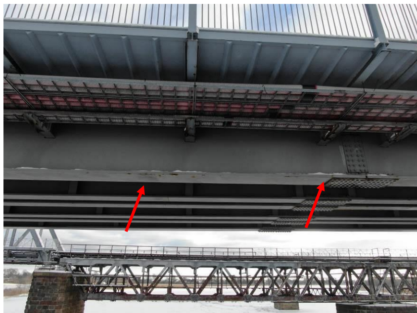
25. att. Sijām vietām sākusies korozija. Skats uz 3.laidumu no apakšas lejteces puses.
