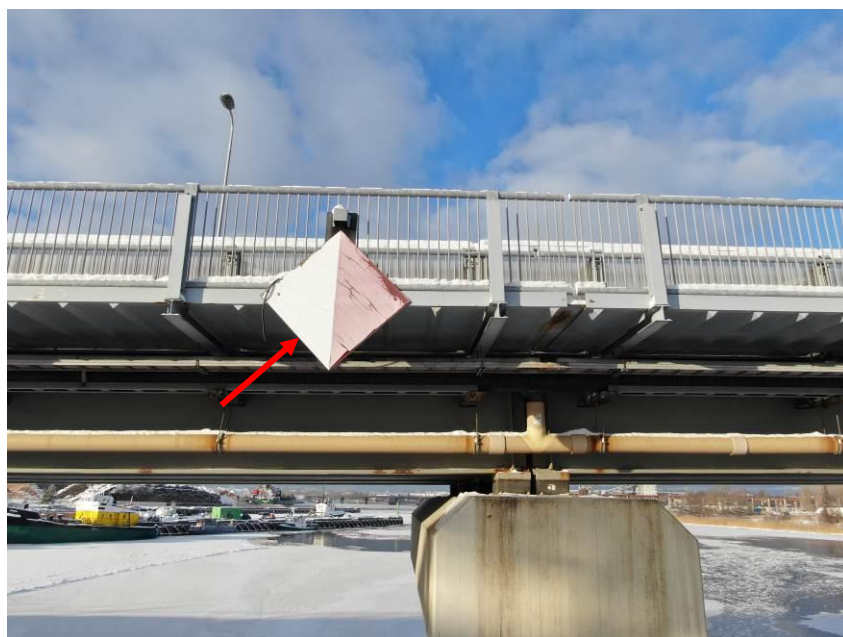
53.att. Nolietojusies kuģošanas zīme. Skats pie upes balsta Nr.2 augšteses pusē.
