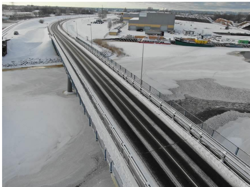
3.att. Pretslīdes pārklājums uz brauktuves. Skats uz brauktuvi no augšas Pārventas puses.
