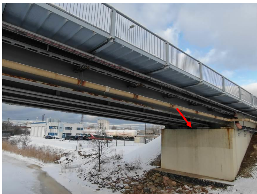
46.att. Brauktuves virsmas ūdens tek uz balstīklām, korodē to tērauda daļas. Skats uz krasta balstu Nr.1.
