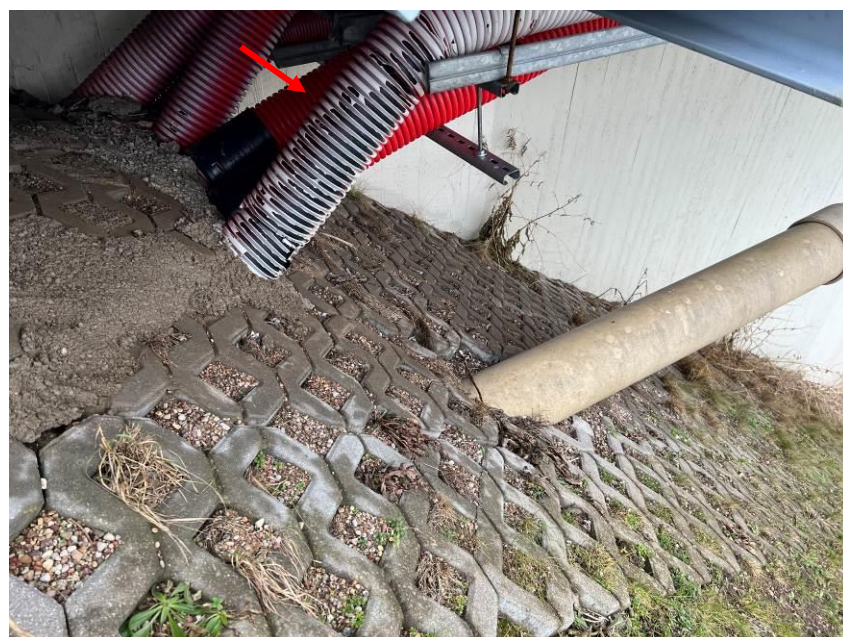
54.att. Nolietojusies komunikāciju aizsargcaurule-pie demontāžas var salūzt. Skats pie krasta balsta Nr.1 lejtes pusē.
