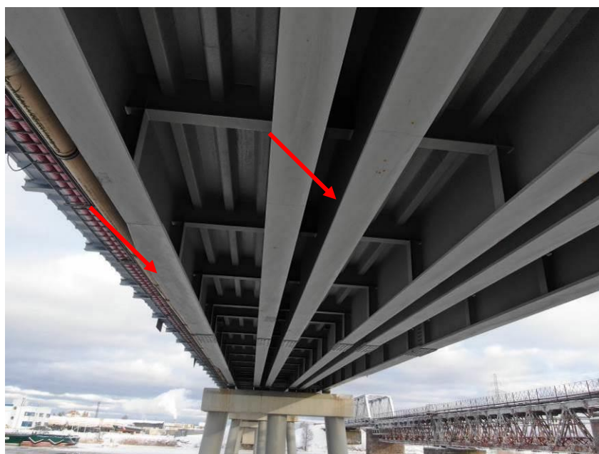
20.att. Sijām vietām sākusies korozija. Skats uz 1.laidumu no apakšas.
