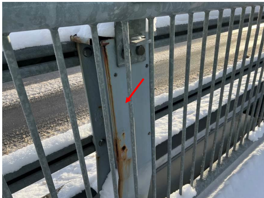
11.att. Stipra barjeras stabiņa korozija augšdaļā. Skats 4.laidumā lejteces pusē.
