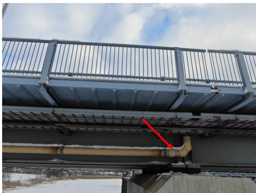
44.att. Brauktuves virsmas ūdens tek uz balstīklām, korodē to tērauda daļas. Skats uz upes balsta uzkalu Nr.4 no lejteces puses.
