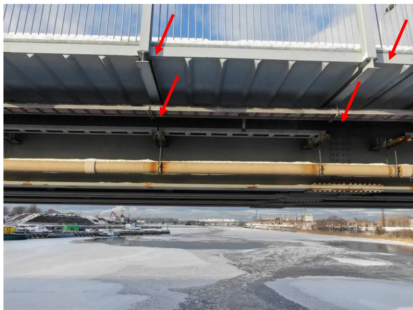
16.att. Stipra barjeras stabiņa konstrukcijas korozija lejasdaļā pie sijas stiprinājuma. Stipri korodē komunikāciju kronšteins. Vietām korozija ietves konstrukcijā Skats 2.laidumā augšteces pusē.
