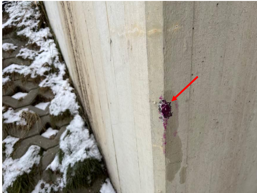
33.att. Karbonizācijas dziļuma mērījums balsta ķermenim (0-2mm). Skats uz krasta balstu Nr.1 lejteces pusē.
