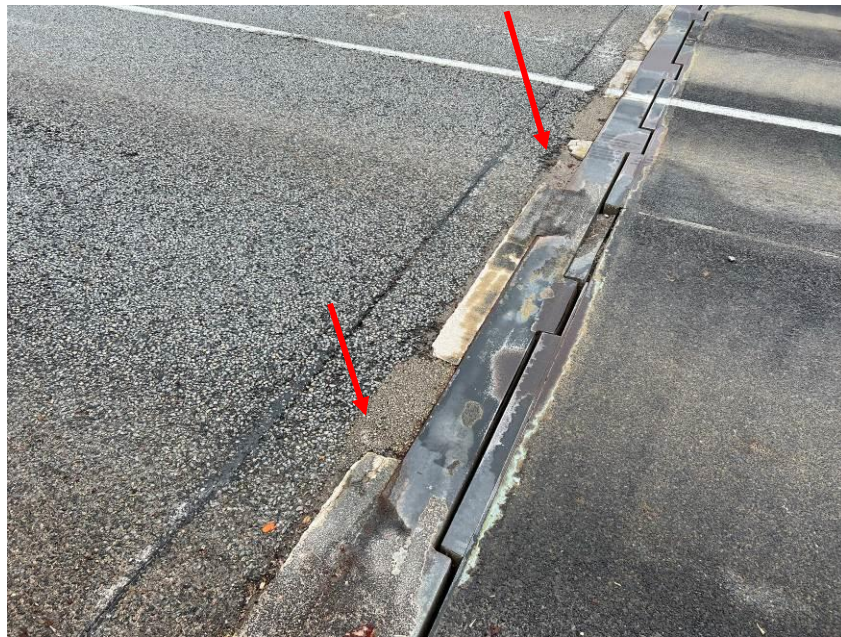
7.att. Pretslīdes pārklājuma, šuves sliekšņa un asfaltbetona seguma bojājumi uz brauktuves pie deformācijas šuves. Skats uz brauktuvi virs krasta balsta Nr.5.
