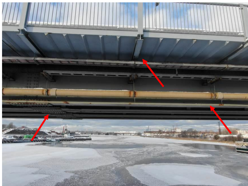
24.att. Sijām vietām sākusies korozija. Korodē arī ietves konstrukcija. Skats uz 2.laidumu no apakšas augšteces puses.
