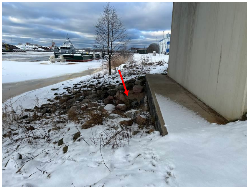
47.att. Trūkst krasta nostiprinājum akmeņi. Skats pie krasta balsta Nr.5.
