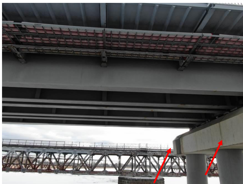
40.att. Notecējumi uz balsta uzkalas, notiek ķīmiski procesi betonā – veidojas plaisu tīkls. Skats uz upes balstu Nr.3 no Pārventas puses.
