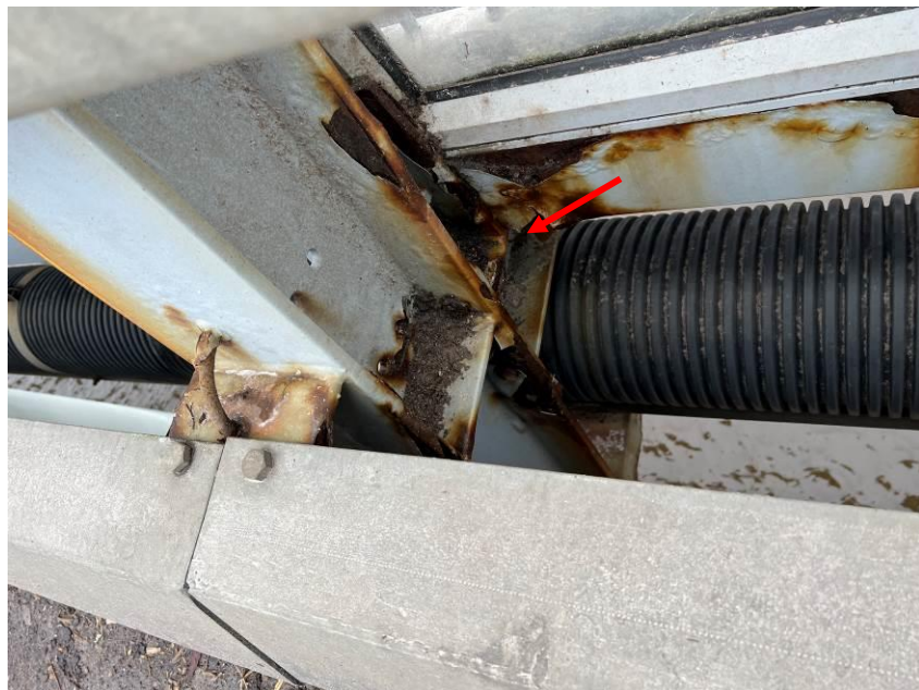
10.att. Stipra barjeras stabiņa korozija lejasdaļā pie sijas stiprinājuma. Skats 1.laidumā lejteces pusē.
