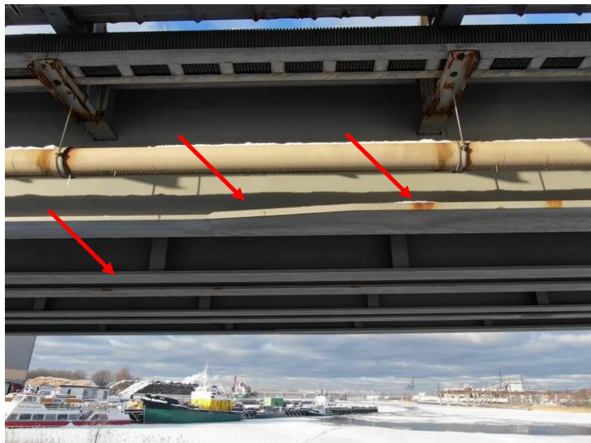
21.att. Sijām vietām sākusies korozija. Skats uz 1.laidumu no apakšas augšteces puses.
