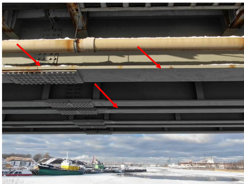
22.att. Sijām savienojuma sākusies korozija. Skats uz 1.laidumu no apakšas augšteces puses.
