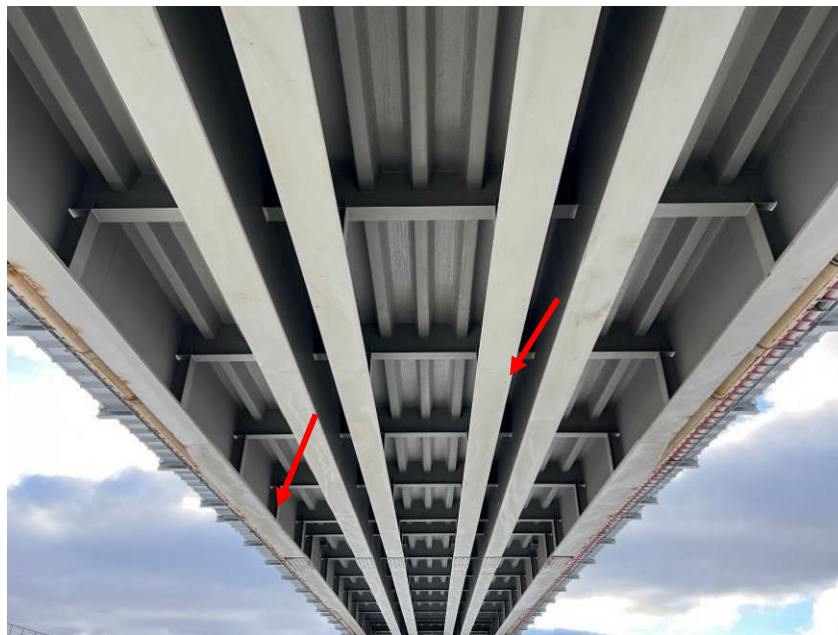
29.att. Sijām vietām sākusies korozija. Skats uz 4.laidumu no apakšas.
