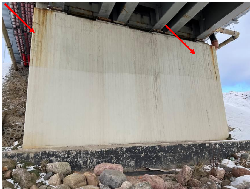
45.att. Notecējumi uz balsta ķermeņa, notiek ķīmiski procesi betonā – veidojas plaisu tīkls. Skats uz krasta balstu Nr.5 no augšteces.
