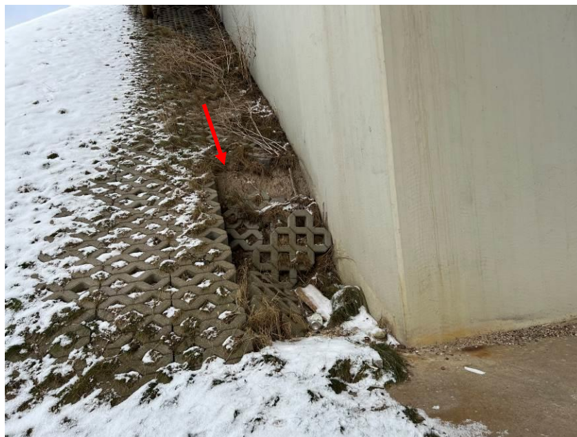
48.att. Bojāts konusa nostiprinājums. Skats uz krasta balstu Nr.5 lejtecis pusē.
