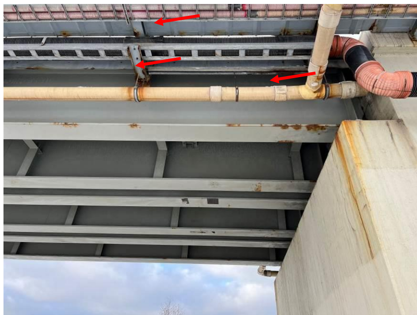
14.att. Stipra barjeras stabiņa konstrukcijas korozija lejasdaļā pie sijas stiprinājuma. Stipri korodē komunikāciju kronšteins. Vietām korozija ietves konstrukcijā . Skats 4.laidumā augšteces pusē.
