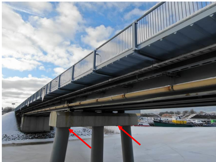
37.att. Notecējumi uz balsta uzkalas, notiek ķīmiski procesi betonā – veidojas plaisu tīkls. Lokāli krāsojuma bojājumi statiem. Skats uz upes balstu Nr.2 no Pārventas puses.
