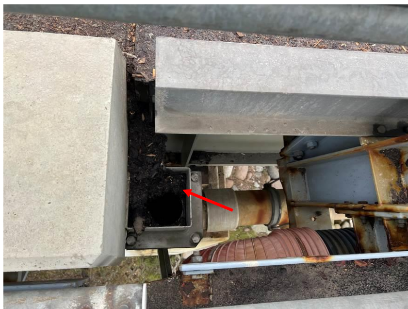
52.att. Sanesumi vaļēja tipa virsmas ūdens uztvērjkonstrukcijā. Skats pie krasta balsta Nr.1 lejtes pusē.
