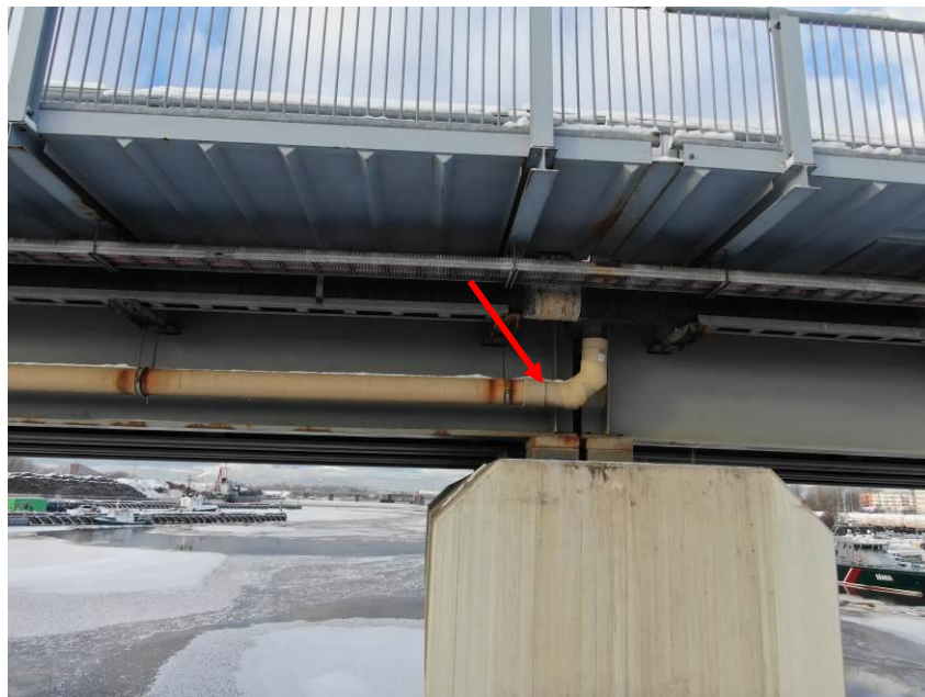
41.att. Brauktuves virsmas ūdens tek uz balstīklām, korodē to tērauda daļas. Skats uz upes balsta uzkalu Nr.3 no augšteces puses.
