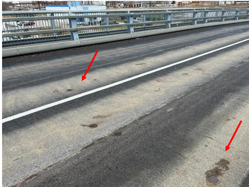
5.att. Pretslīdes pārklājuma bojājumi uz brauktuves. Skats 3.laidumā.
