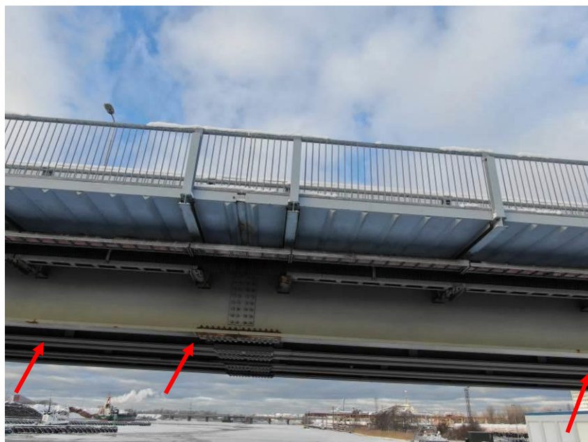
26. att. Sijām vietām sākusies korozija. Skats uz 3.laidumu no apakšas augšteces puses.
