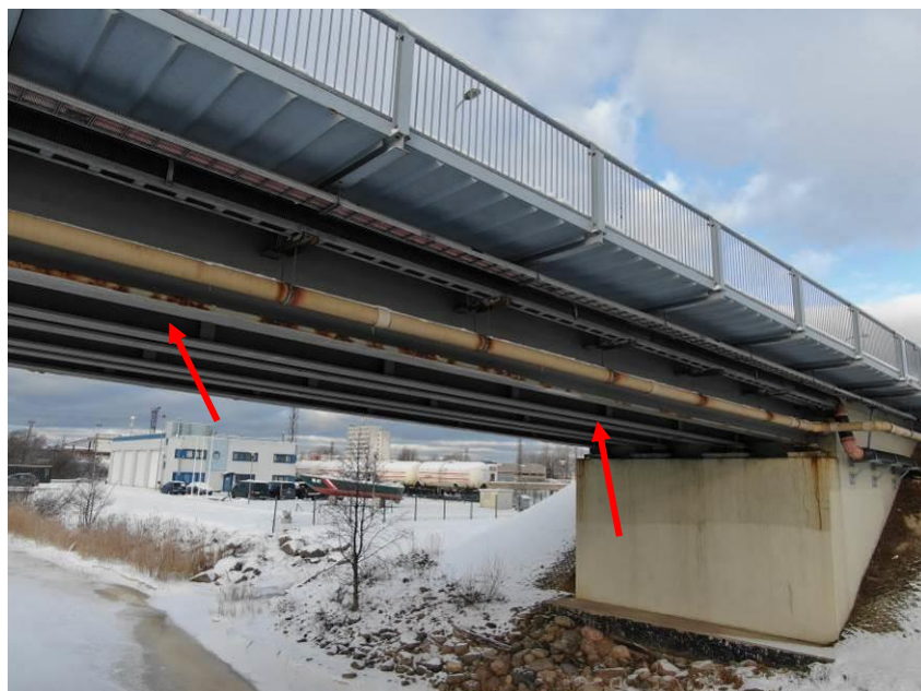
28.att. Fasādes sijām korozija. Skats uz 4.laidumu no apakšas augšteces puses.
