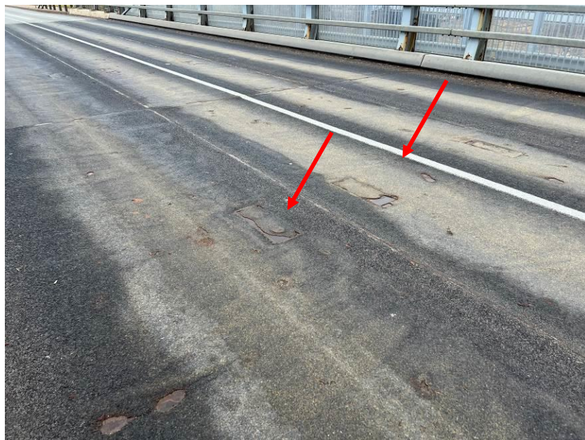
6.att. Pretslīdes pārklājuma bojājumi uz brauktuves. Skats 4.laidumā.
