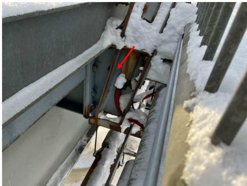
12.att. Stipra barjeras stabiņa korozija lejasdaļa pie sijas stiprinājuma. Skats 3.laidumā lejteces pusē.
