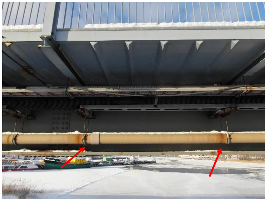
49.att. Rūsas notecējumi no komunikāciju kronšteinu tek uz virsmas ūdens atvades caurulēm. Skats 1.laidumā augštecē.
