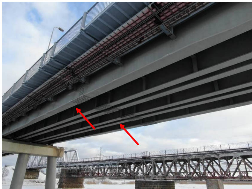
23.att. Korozija ietves konstrukcijā. Skats 2.laidumā lejteces pusē.
