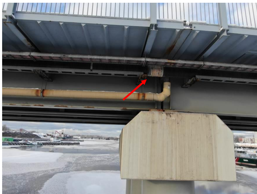
51.att. Notiek noplūde no komunikācijām. Skats virs upes balsta Nr.3 augštes pusē.
