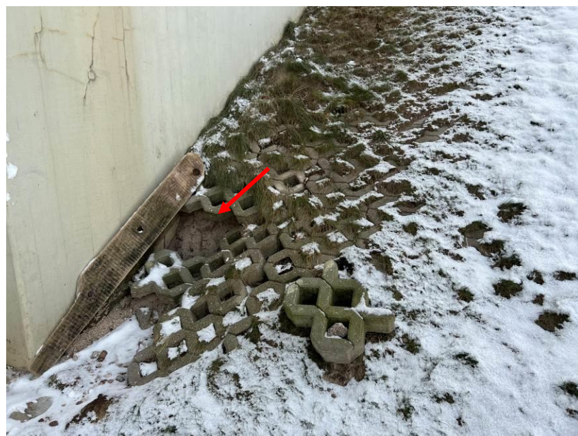
32.att. Bojāts konusa nostiprinājums. Skats uz krasta balstu Nr.1 lejteces pusē.
