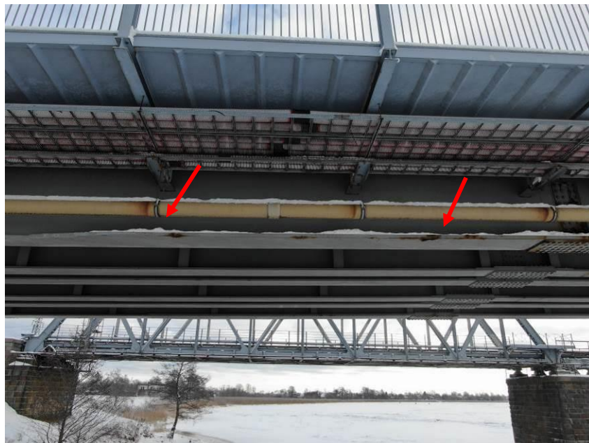
27.att. Sijām korozija. Skats uz 4.laidumu no apakšas lejteces puses.
