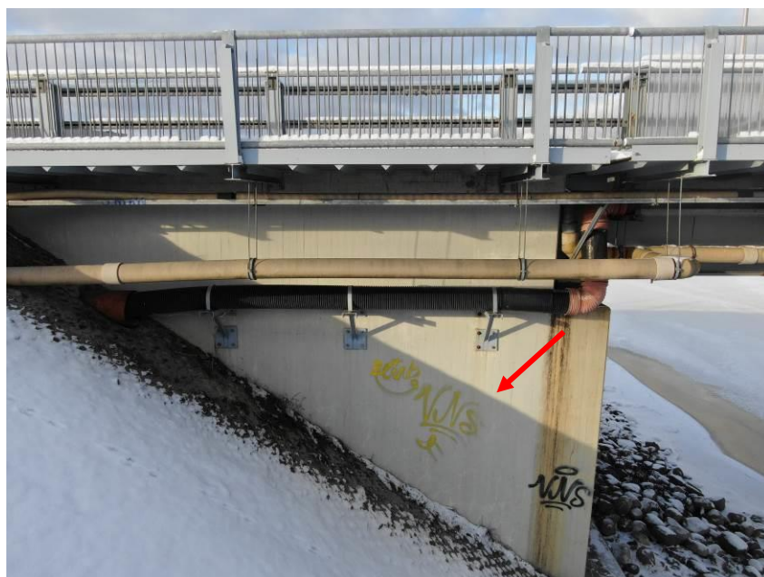
31.att. Notecējumi uz balsta ķermeņa, notiek ķīmiski procesi betonā – veidojas plaisu tīkls. Grafiti zīmējumi. Skats uz krasta balstu Nr.1 no augšteces.
