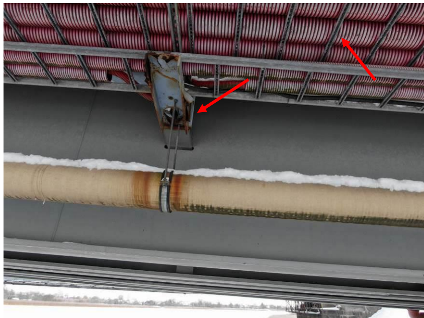
17.att. Stipra barjeras stabiņa konstrukcijas korozija lejasdaļā pie sijas stiprinājuma. Stipri korodē komunikāciju kronšteins. Nolietojusies komunikāciju aizsargcaurule - pie demontāžas tās var salūzt Skats 1.laidumā lejteces pusē.
