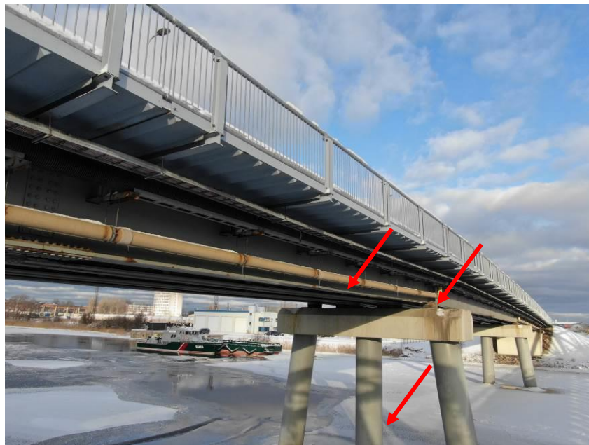
39.att. Notecējumi uz balsta uzkalas, notiek ķīmiski procesi betonā – veidojas plaisu tīkls. Lokāli krāsojuma bojājumi statiem. Skats uz upes balstu Nr.3 no Centra puses.
