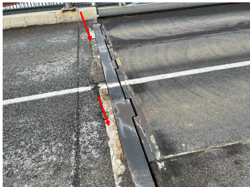
4.att. Pretslīdes pārklājuma, šuves sliekšņa un asfaltbetona seguma bojājumi uz brauktuves pie deformācijas šuves. Skats uz brauktuvi virs krasta balsta Nr.1.
