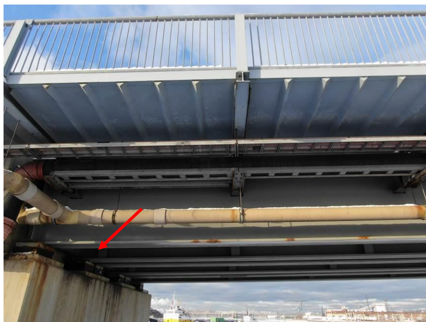
35.att. Brauktuves virsmas ūdens tek uz balstīklām, korodē to tērauda daļas. Skats uz krasta balstu Nr.1.
