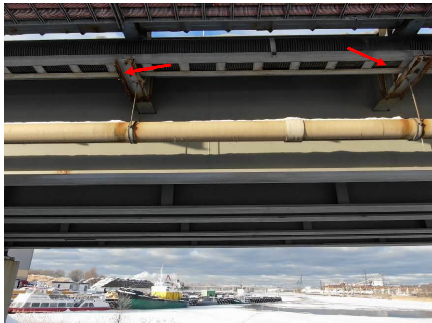
15.att. Stipra barjeras stabiņa konstrukcijas korozija lejasdaļā pie sijas stiprinājuma. Stipri korodē komunikāciju kronšteins. Skats 1.laidumā augšteces pusē.
