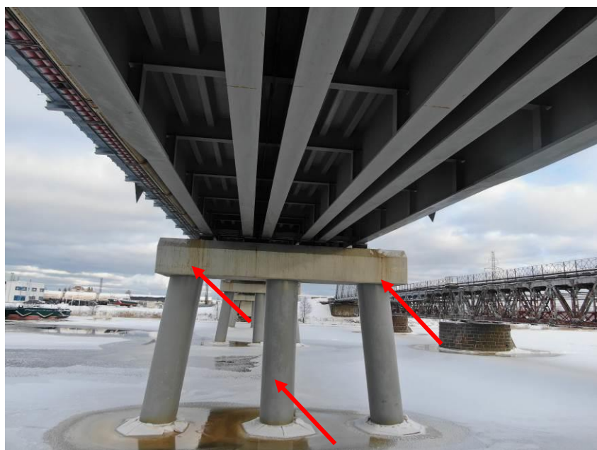
36.att. Notecējumi uz balsta uzkalas, notiek ķīmiski procesi betonā – veidojas plaisu tīkls. Lokāli krāsojuma bojājumi statiem. Skats uz upes balstu Nr.2 no Centra puses.
