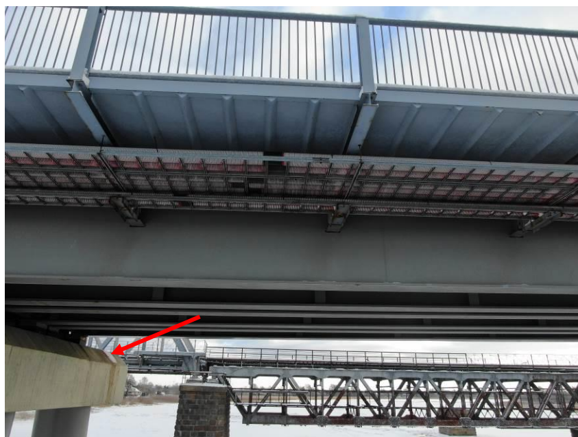
43.att. Brauktuves virsmas ūdens tek uz balstīklām, korodē to tērauda daļas. Skats uz upes balsta uzkalu Nr.4 no lejteces puses.
