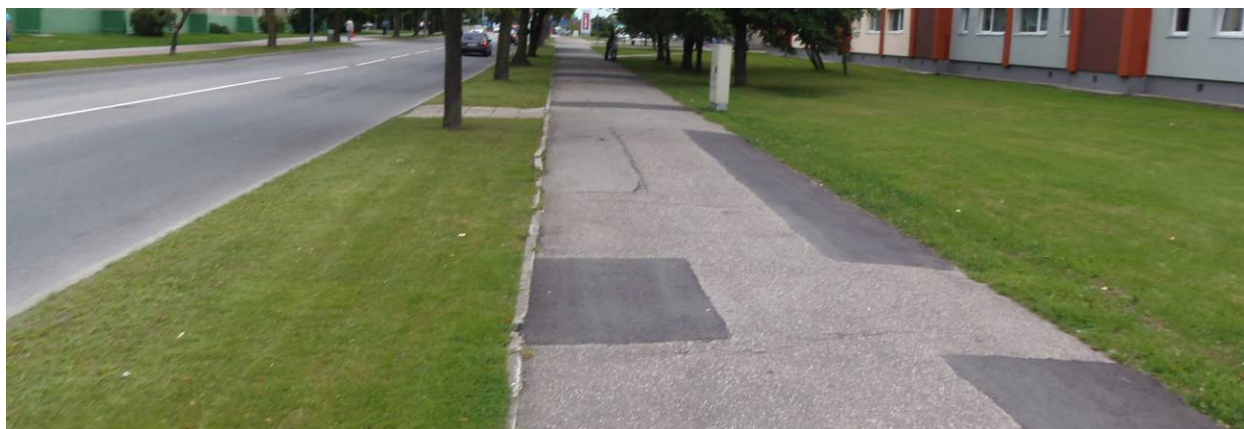
7. att. – atsevišķās bedru vietās veikts seguma remonts, kas kalpo kā pagaidu risinājums
