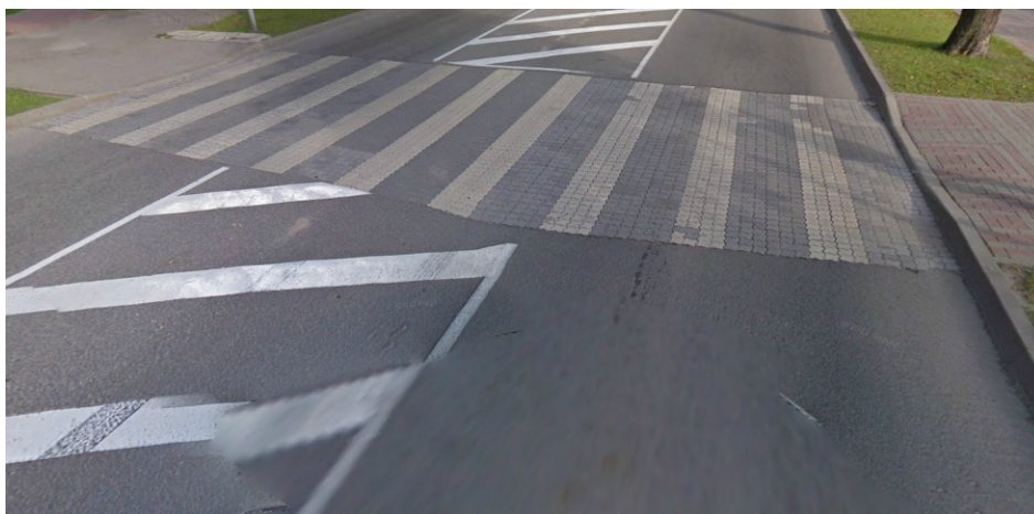
5. att. – brauktuvei konstatētas „risas”, bruģa gājēju pārejas un asfaltbetona seguma salaiduma posmā novērots nekvalitatīvs segumu salaidums, kas palielina bedru rašanās risku.
