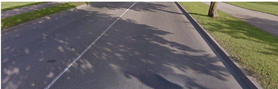
3. att. – seguma garenvirziena plaisa, kas liecina par tā nolietošanās pakāpi
