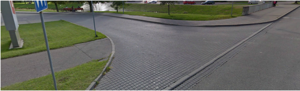
12. att. – nobrauktuvei uz t/c „Tobago” ir nepietiekami liels uzbraukšanas stūra noapaļojums, tādēļ doto stūra noapaļojumu paredzēts izveidot ar stūra līkni
