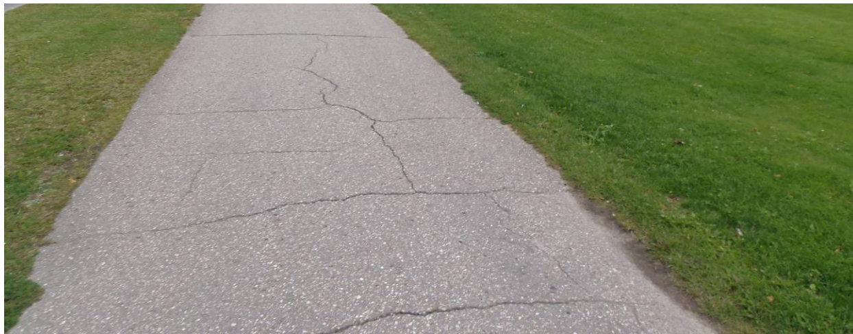
6. att. – ietves asfaltbetona segums ir nodilis un daļēji sabrucis, tam konstatēts plašs plaisu tīkls
