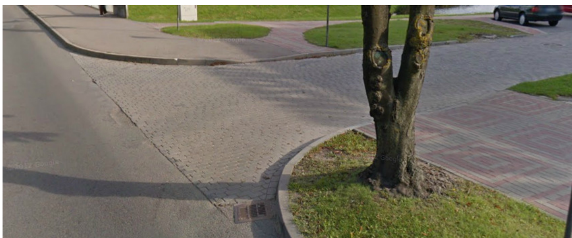
11. att. – nekvalitatīvs ceļa segumu salaidums starp ielas pamatbrauktuvi un nobrauktuvi uz blakus esošu teritoriju
