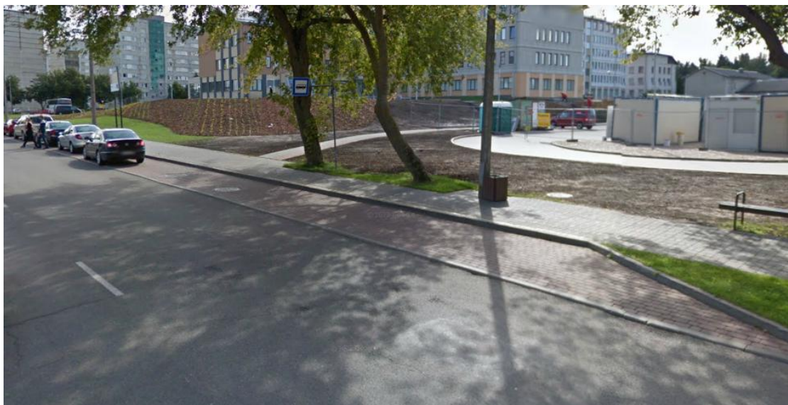
7. att. – pieturvietas paplašinājums apvienots ar stāvvietām brauktuves malā, nav uzklāti atbilstoši ceļa horizontālie apzīmējumi
