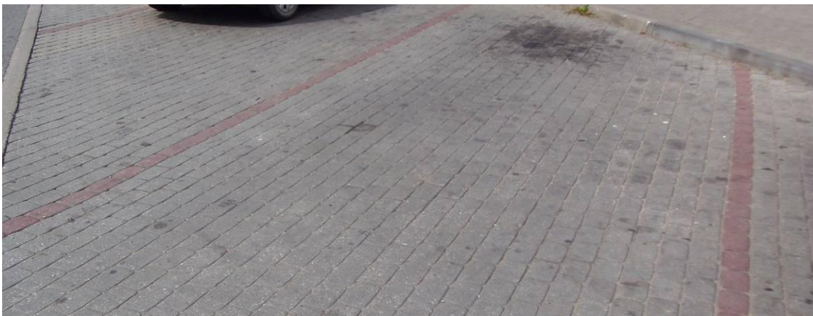
9. att. – ir ceļa apzīmējumi, bet nav izveidotas invalīdu stāvvietas, stāvvietu parametri neatbilst standarta prasībām, konstatēti atsevišķu apmaļu bojājumi
