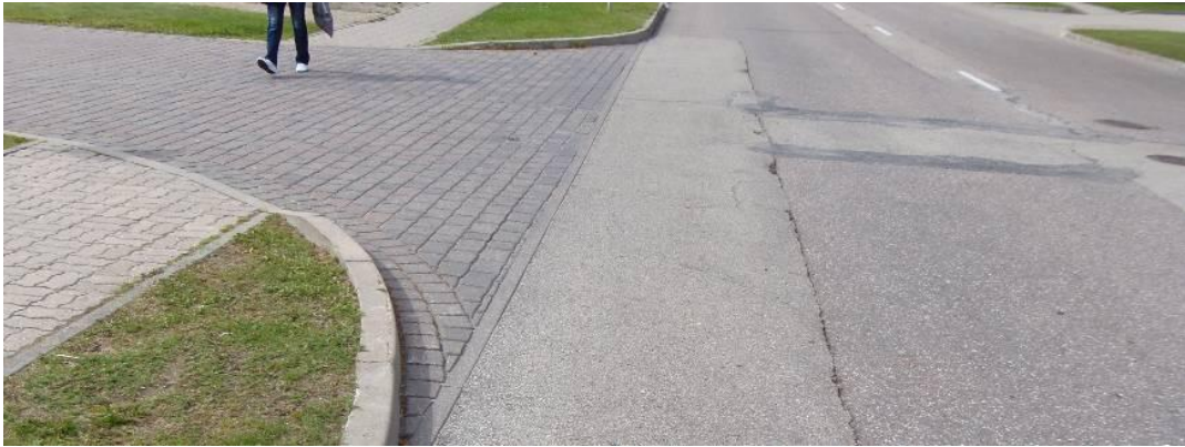
4. att. – remontdarbu laikā nekvalitatīvi veikti seguma remonta darbi, kas vēl vairāk pasliktina ceļa seguma ekspluatācijas īpašības
