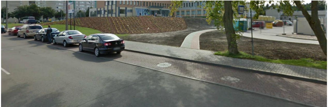
9. att. – brauktuves labās puses stāvvietu ceļa sega ir apmierinošā tehniskā stāvoklī, tomēr nav uzklāti atbilstoši ceļa apzīmējumi, nav izveidotas invalīdu stāvvietas
