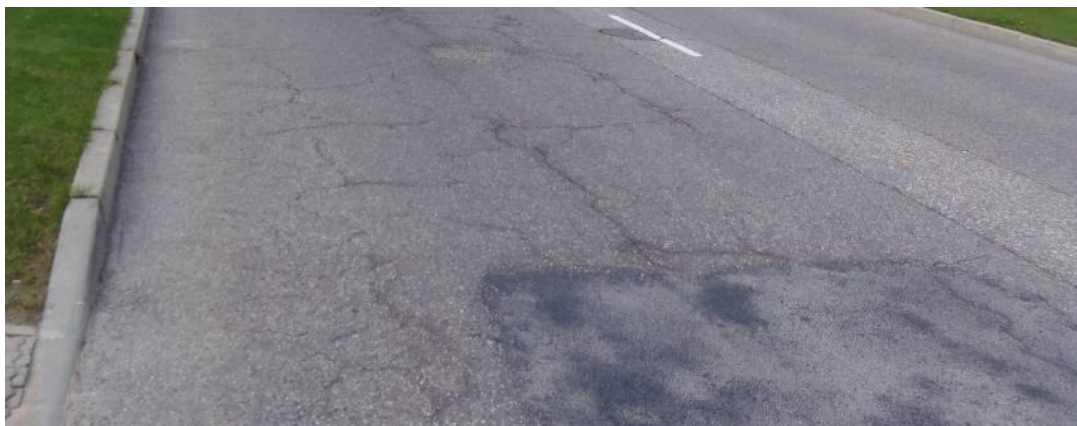
5. att. – plaisas un asfalta seguma bedru „ielāpi” liecina par pamata nestspējas zudumu
