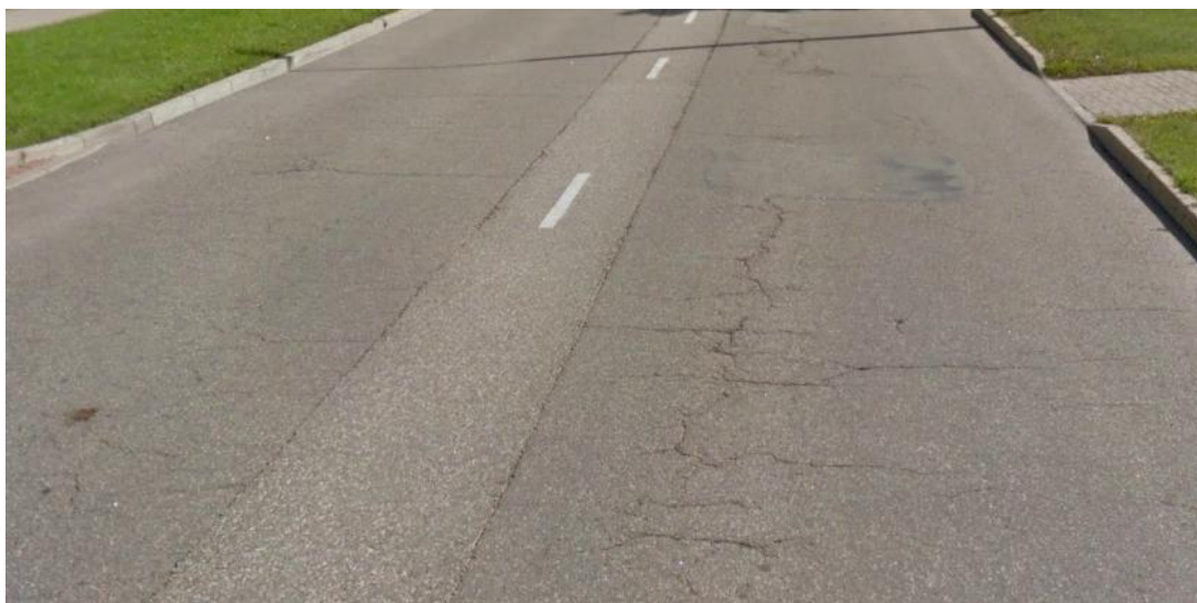
3. att. – atsevišķu ielas posmu ceļa segums ir stipri nodilis, tajā ir izveidojies plaisu tīkls
