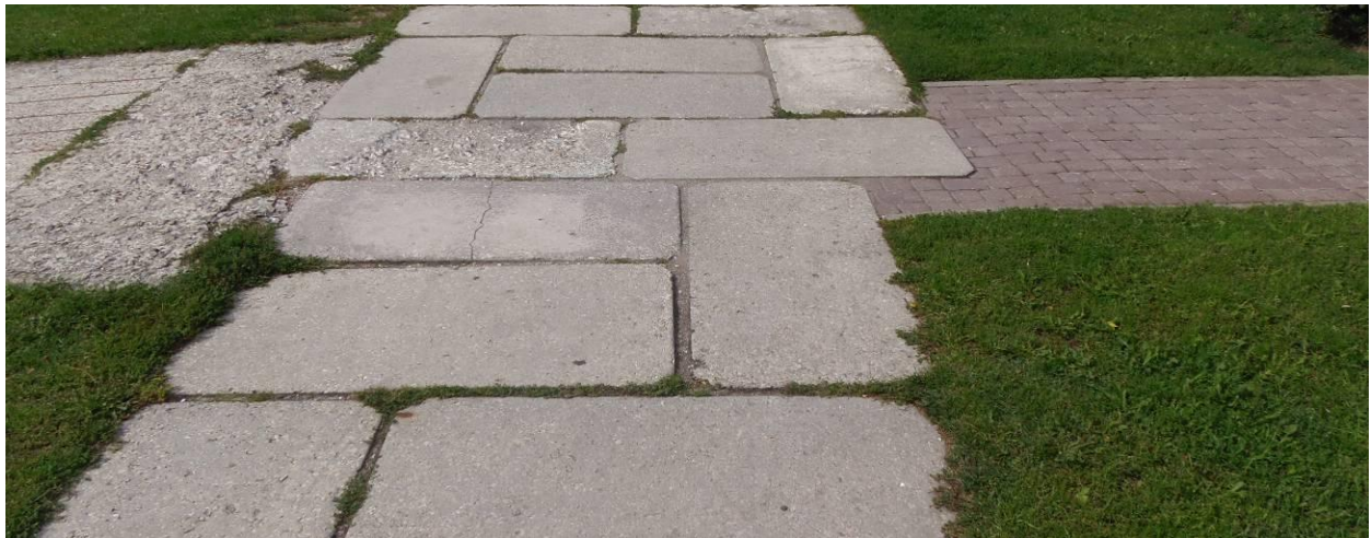
6. att. – ietves betona plātņu segums ir nodilis un daļēji sabrucis, nepieciešama jauna ietves sega
