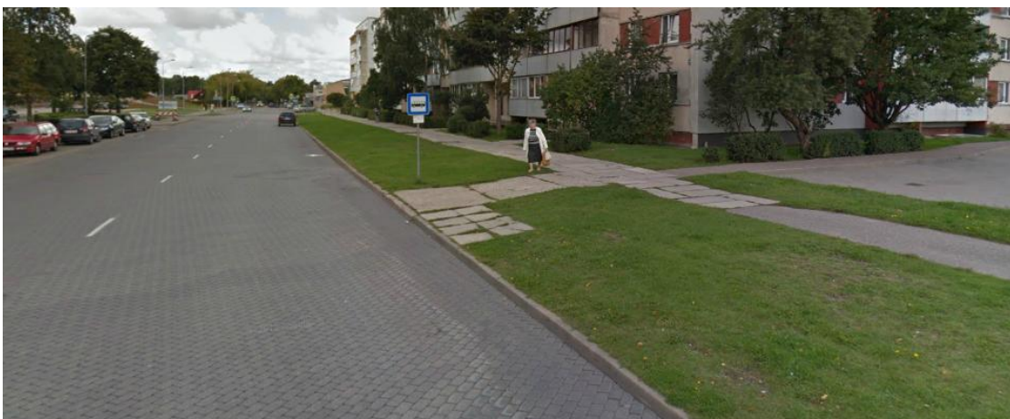
8. att. – pieturvietai nav izveidots brauktuves paplašinājums un standarta prasībām atbilstoša gājēju platforma
