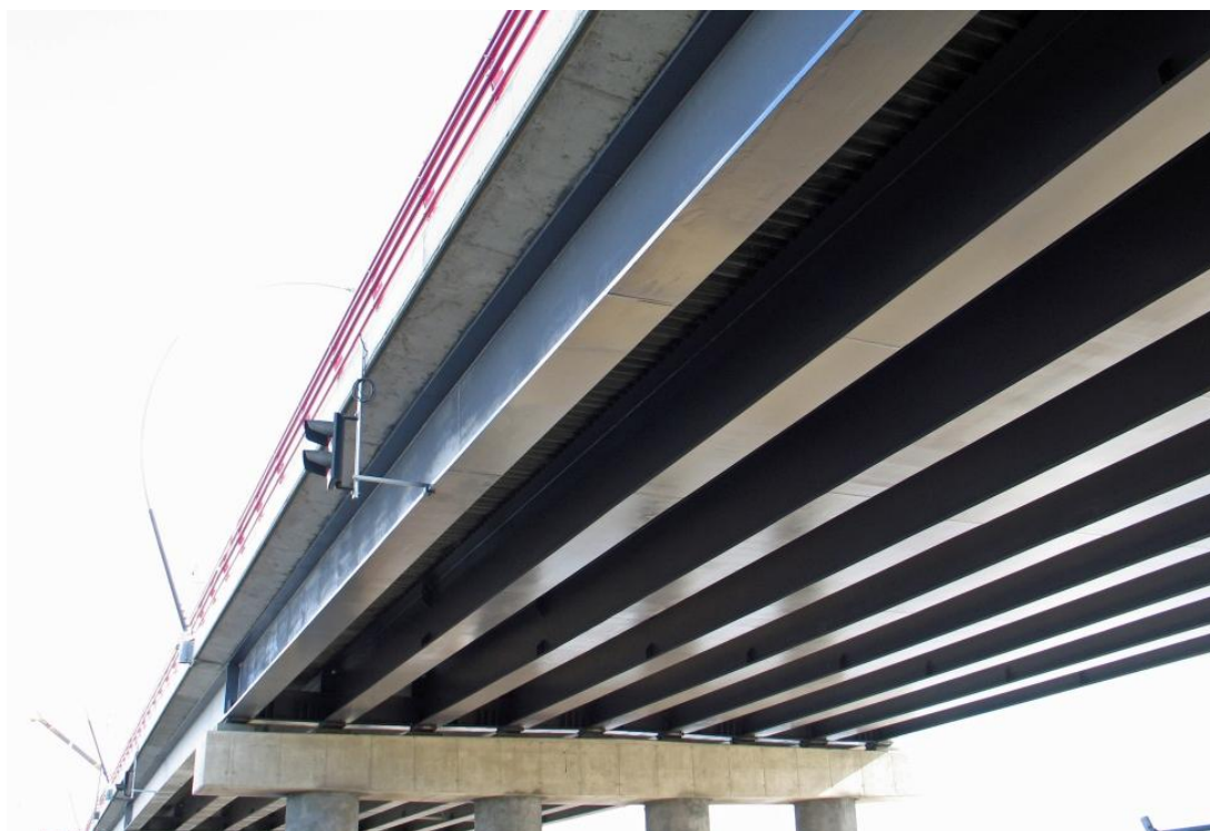
7.att Tēraudbetona laiduma konstrukcija.
