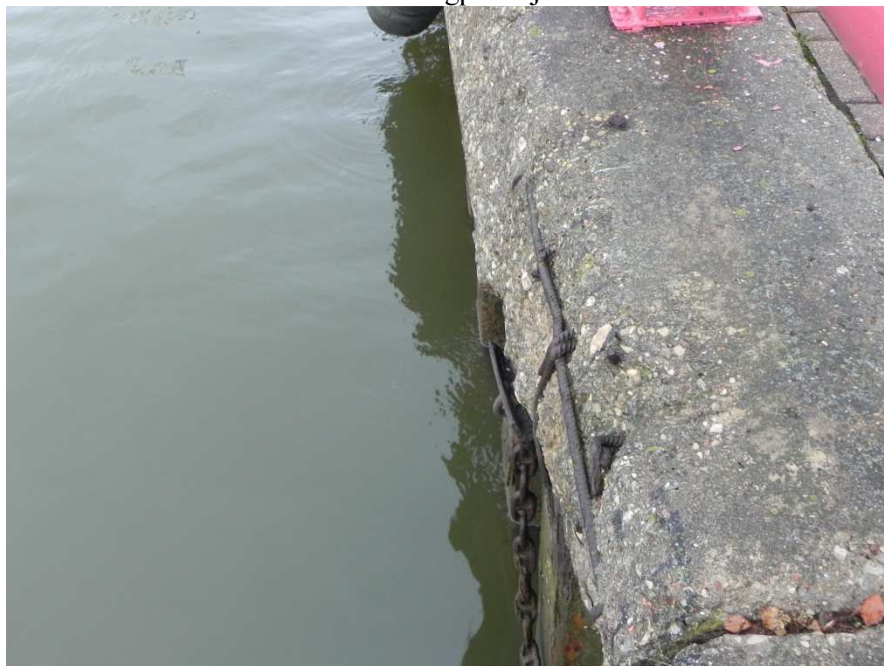
4.att. Bojāta betona aizsargkārtā.
