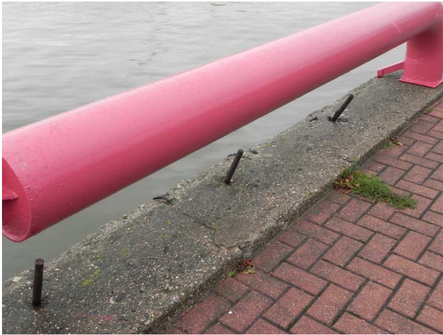
3.att. Bojāti atvairbrusas stiprinājumi.
