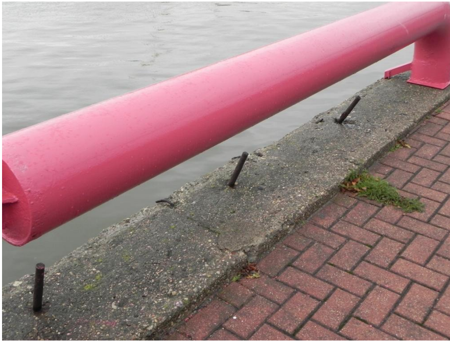
3.att. Bojāti atvairbrusas stiprinājumi.
