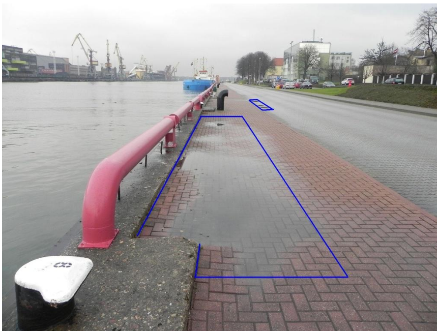
1.att. Piemērs - seguma remonta robežas.
