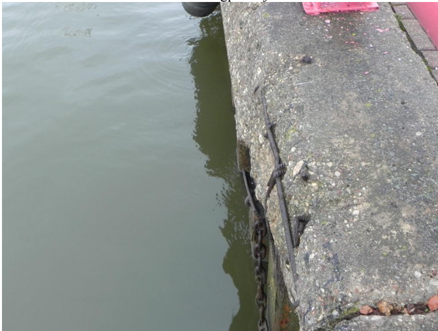
4.att. Bojāta betona aizsargkārtā.
