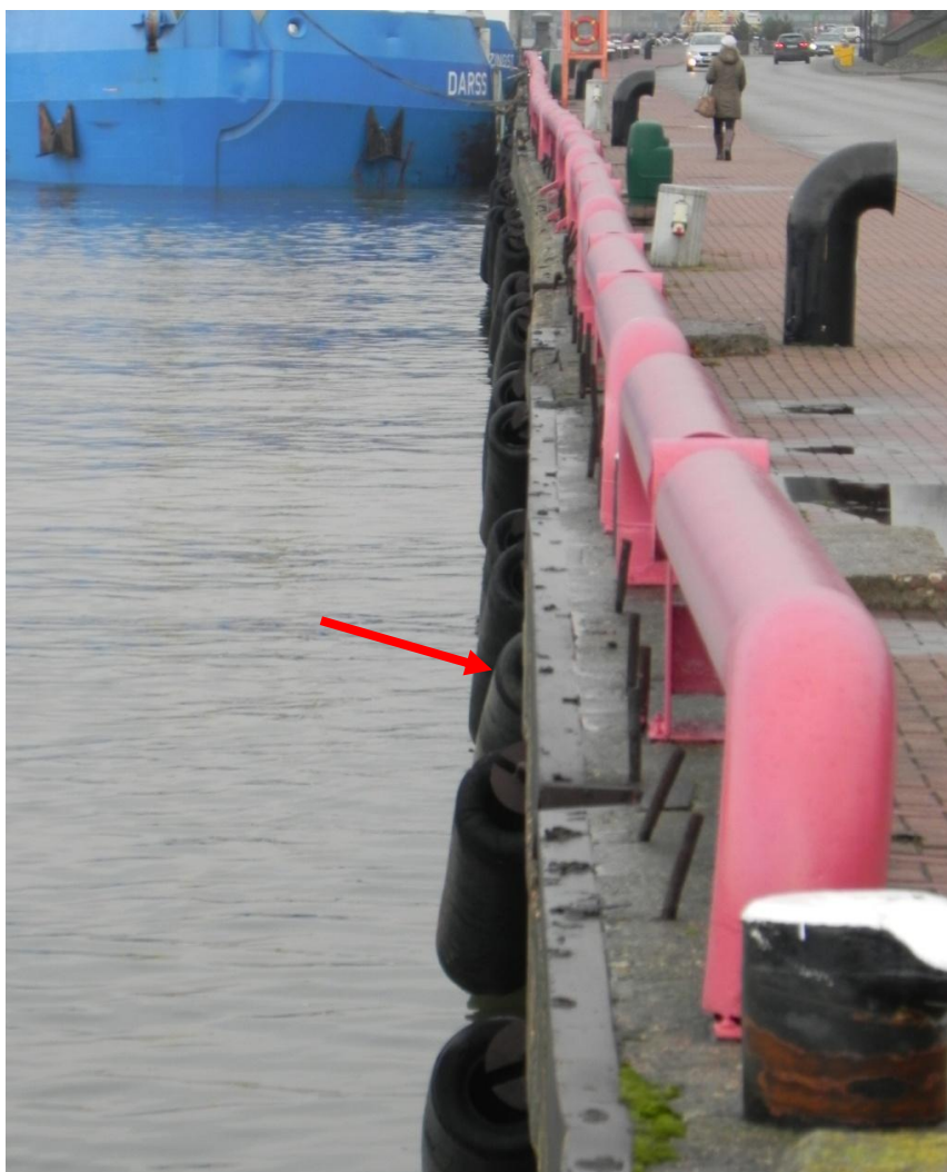
7.att. Esošās atvairierīces. Atvairierīces atrodas zem dz. bet. virsbūves.
