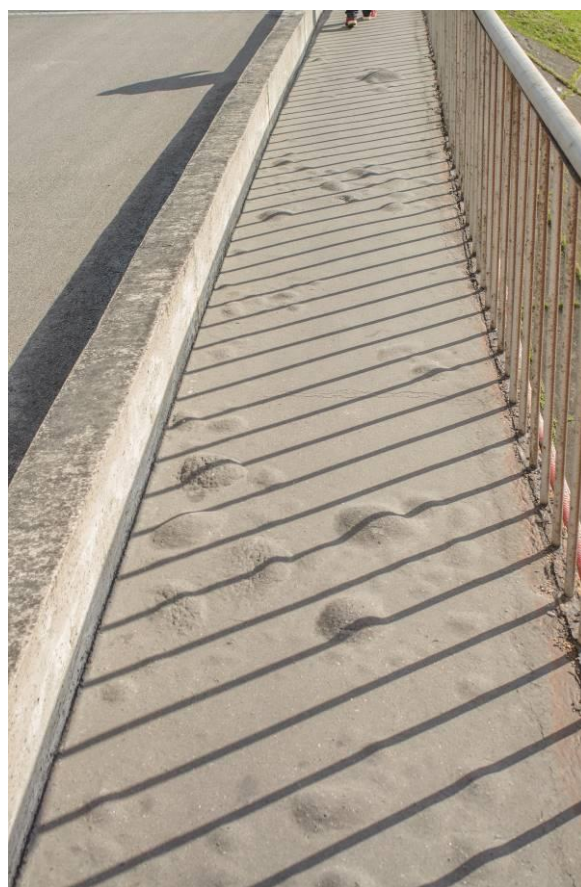
12. att. Asfalta mastikas šuve (pa kreisi) un ietves segums (pa labi)
