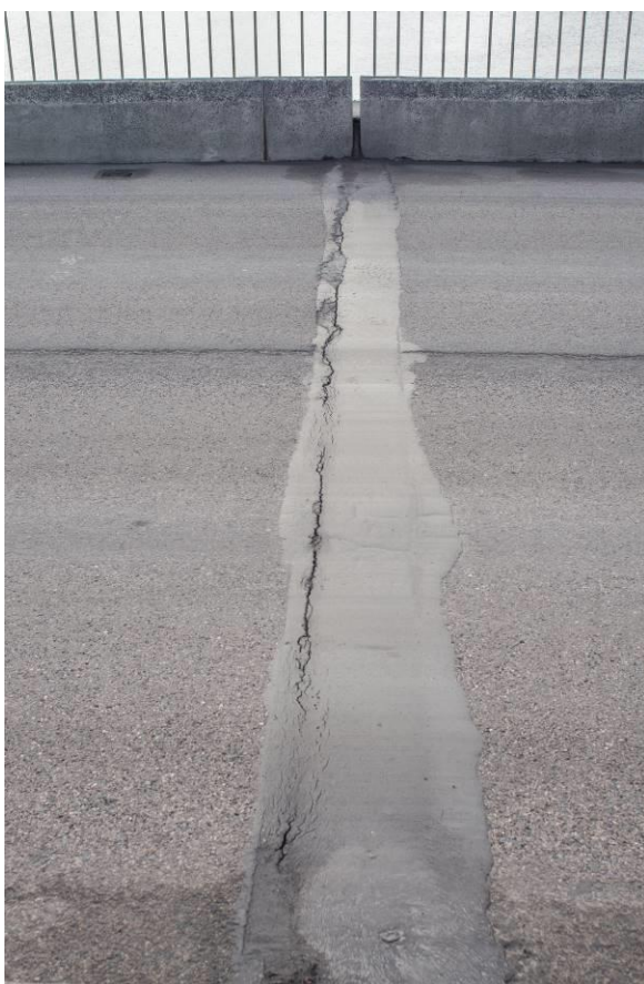
12. att. Asfalta mastikas šuve (pa kreisi) un ietves segums (pa labi)
