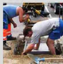
Umfüllung der eingesetzten Einheit und Anfertigung einer Betonanschleife am gesamten Umfang der Edelstahlkonstruktion (siehe technische Zeichnung).
