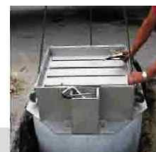
Abheben der gesamten Einheit in die vorbereitete Baugrube mit entsprechenden Hilfsmitteln (Kran).
