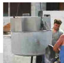
Die auf dem Betonring montierte Edelstahlkonstruktion wird für das Versetzen vorbereitet. Öffnungen für die Zulieferung werden aus dem Betonring herausgeschnitten.
