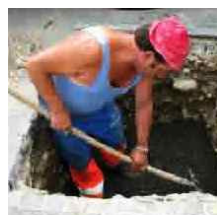
Ausheben der Baugrube aufgrund der erforderlichen Abmessungen. Setzen eines normgerechten Unterbaues sowie einer entsprechenden Drainagegrube
