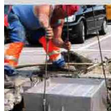
Einpassen der Einheit und Feinverleierung auf die richtige Einbautiefe (Niveau Belagoberfläche).
