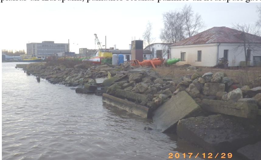
5. Krasta nostiprinājums Jaunās jahtu/zvejas ostas ieejas kanālā. Krasts nostiprināts saimnieciskā kārtā iedzenot dzelzsbetona pāļus un nogāzi nostiprinot ar būvgružiem.
