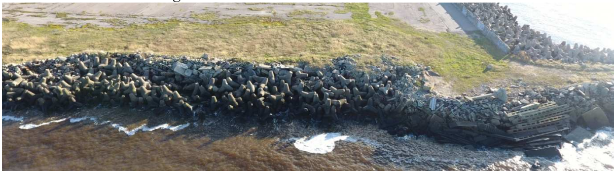
14.att. Skats uz mola nogāzes nostiprinājumu no Jūras puses.
