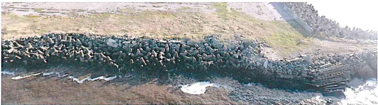
Skats uz mola nogāzes nostiprinājumu no jūras puses.
