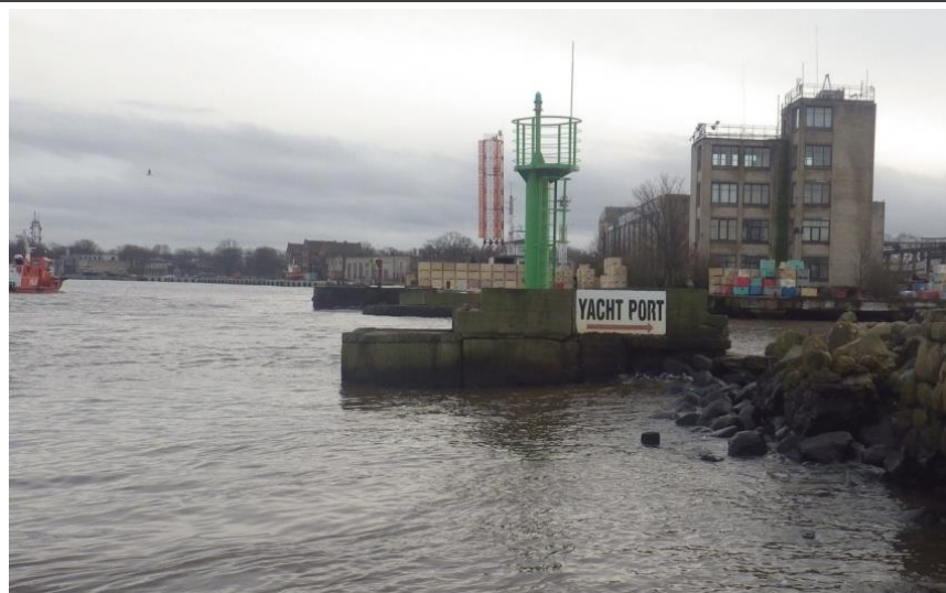
3.att. Skats uz navigācijas zīmi pie ieejas Jaunajā jahtu/zvejas ostā. Navigācijas zīme izvietota uz dzelzbetona pamatnes.
