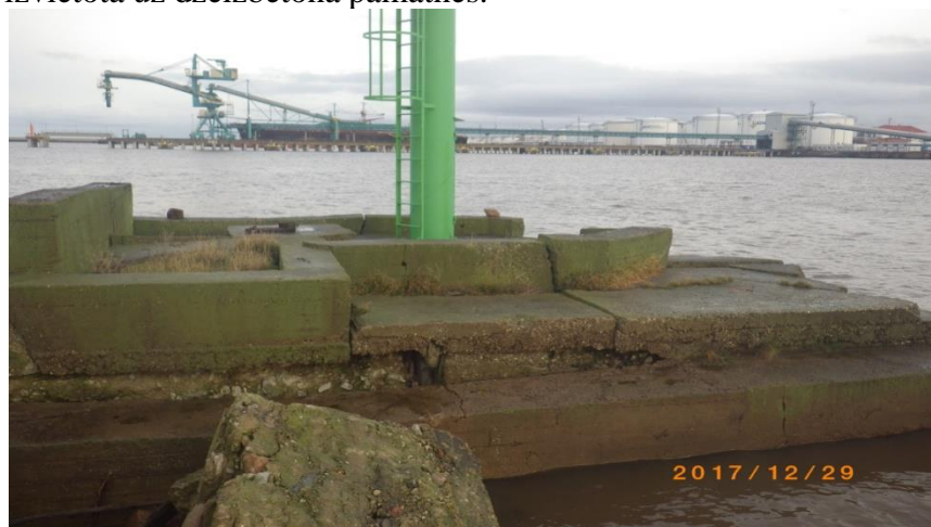
4. att. Navigācijas zīmes betona pamatne betonēta vairākās kārtās. Betonā redzamas plaisas un izdrupumi, pamatnes sēšanās pazīmes un nodrupuši gabali.
