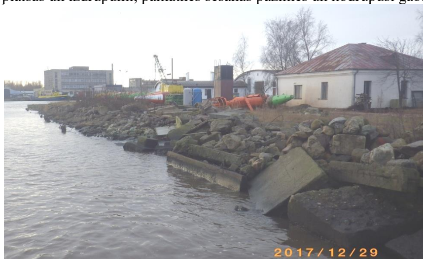
5. Krasta nostiprinājums Jaunās jahtu/zvejas ostas ieejas kanālā. Krasts nostiprināts saimnieciskā kārtā iedzenot dzelzbetona pāļus un nogāzi nostiprinot ar būvgružiem.
