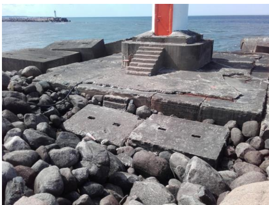
Att. 6. 14 m - mola galvas daļa, kas salikta no betona masīviem. To no 3 pusēm aizsargā betona masīvu krāvējs PK15+8-PK15+22.
