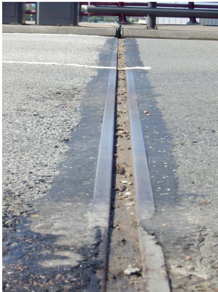
Att. Nr. 9. Nelīdzena seguma pieeja deformācijas šuvei, šuves aizsērējums
