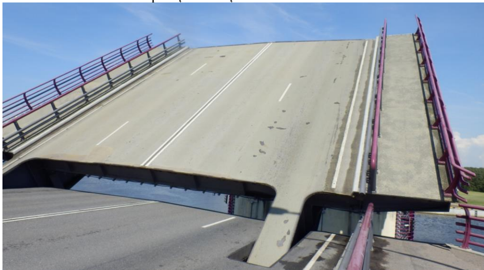
Att. Nr. 4. Tiltā paceģamāģ daģas kreisā krasta brauktuģes defekti
