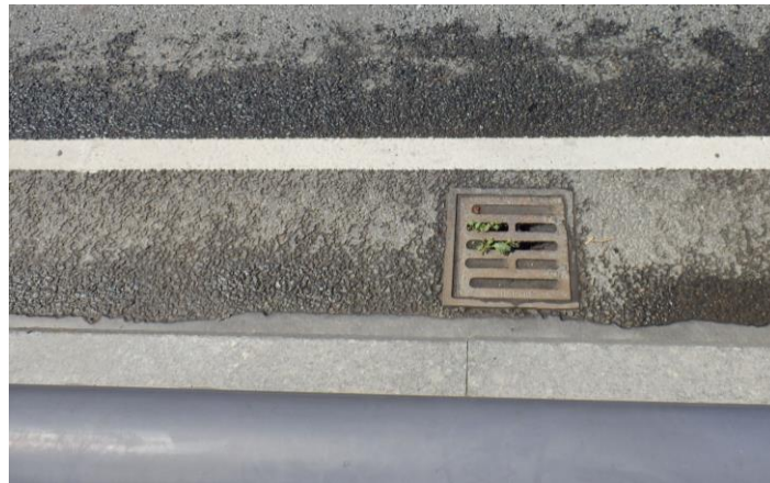
Att. Nr. 9. Nelīdzena seguma pieeja deformācijas šuvei, šuves aizsērējums
