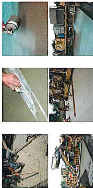
Positiv-Anwendung (Anwendung auf Frischbetonseite):
