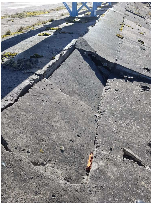
Att.Nr.5. Iebrucis nogāzes nostiprinājums.
