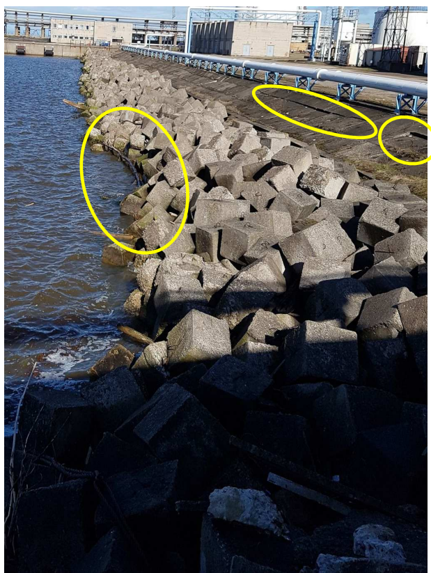
Att.Nr.6. Skats no 3.muliņa uz krasta nostiprinājuma defektiem.
