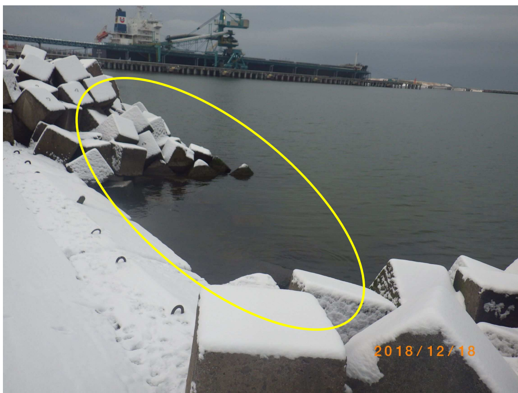
Att.Nr.14. Iztrūkstoša nostiprinājuma posms.
