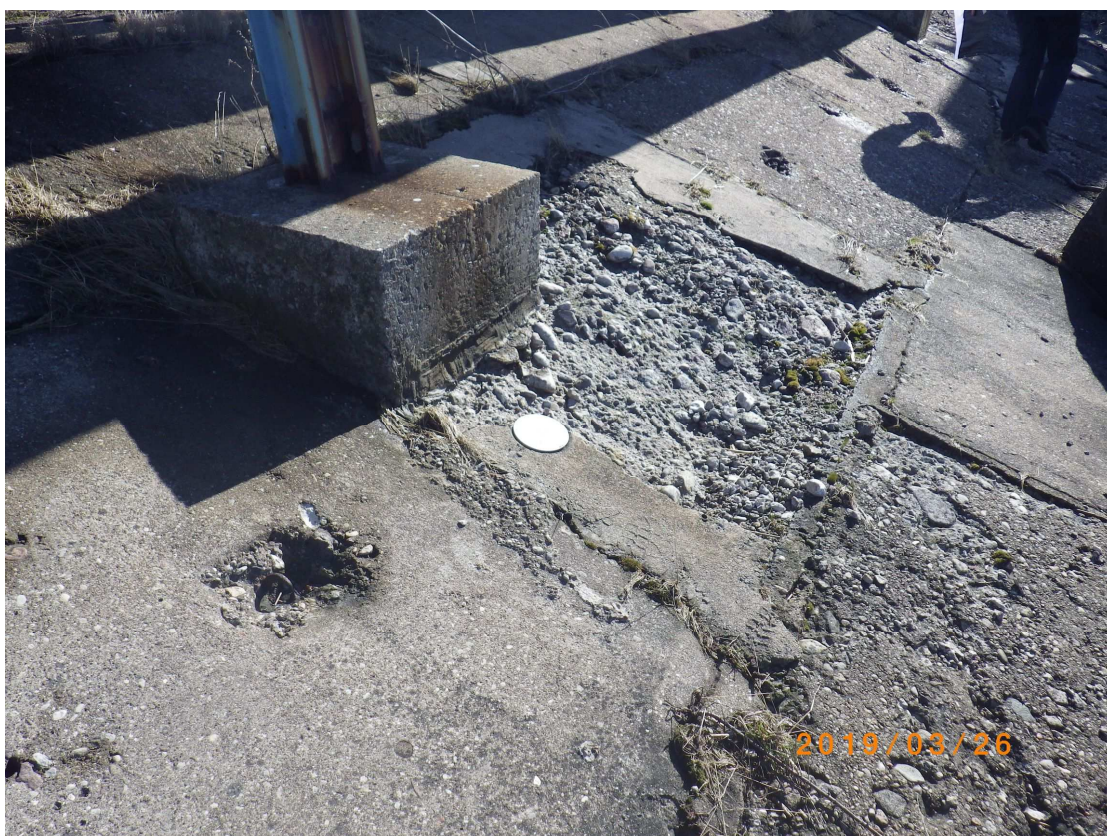
Att.Nr.13. Atsevišķu plātņu virsma stipri sadēdējusi, atsedzot pildvielas.
