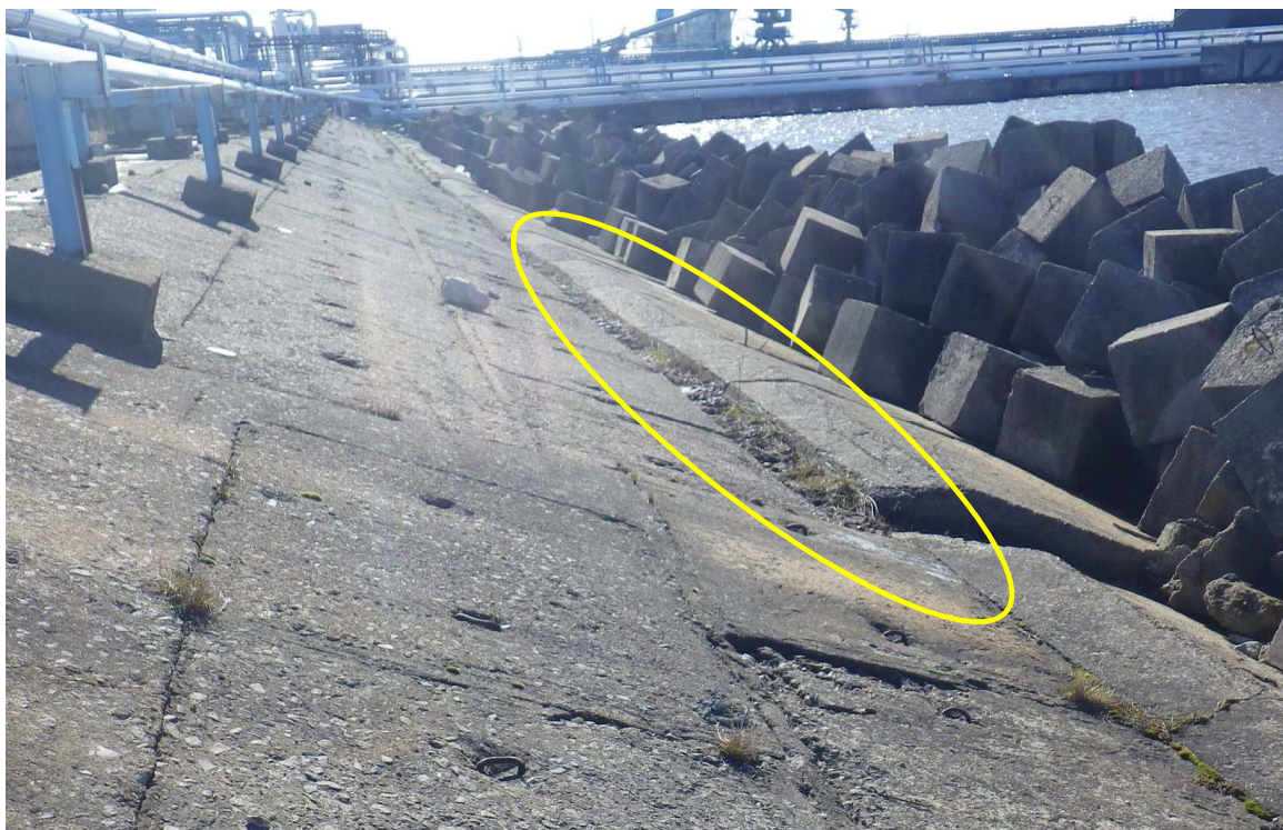
tt.Nr.9. Nosēdušies pamatnes masīvi veidojot spraugu ar plātnēm
