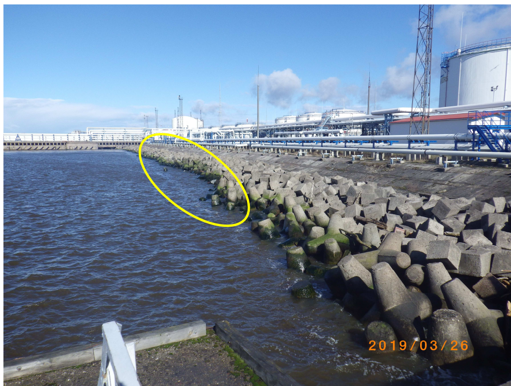
Att.Nr.10. Skats no 2.muliņa virzienā uz 3.muliņu. Vietām jāpapildina betona kubu krāvējs arī no ūdens puses.
