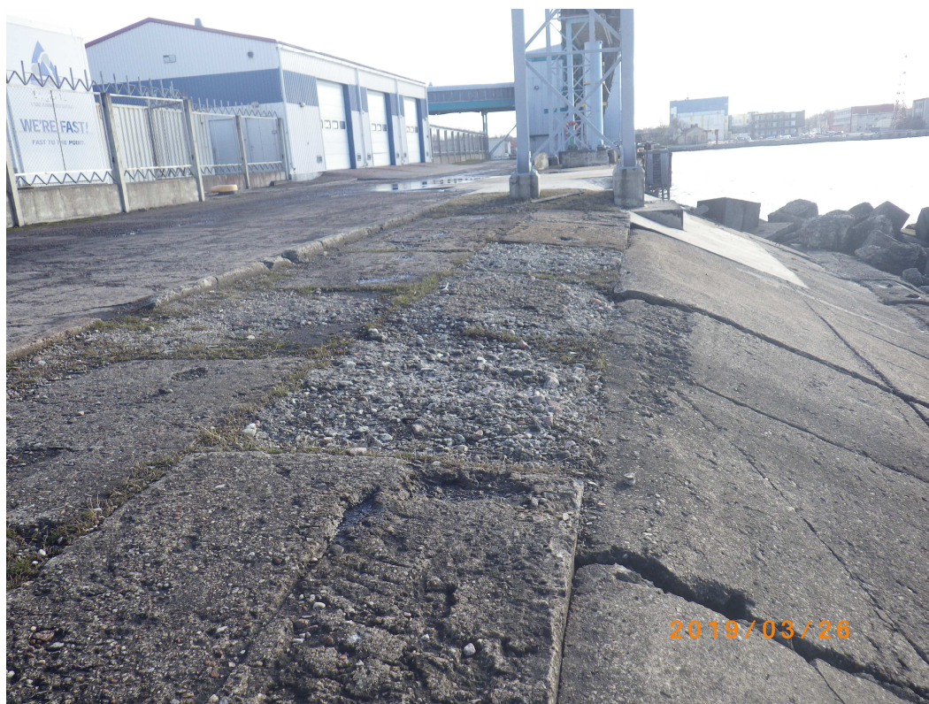
Att.Nr.17. Sadēdējusi plātņu virsma nogāzei pieguļošajā horizontālajā zonā.
