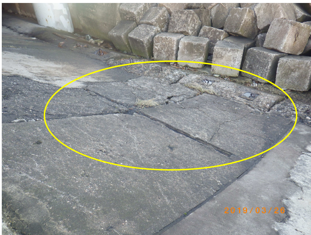
Att.Nr.18. Starp monolīto lējumu joslām palikušas salūzušas plātnes.
