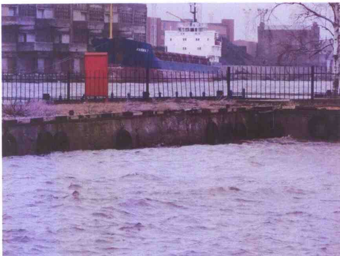
3. attēls. Ventpils brīvostas pārvaldes kuģu stāvēšanas piestātņu fasādes pašreizējais stāvoklis.
