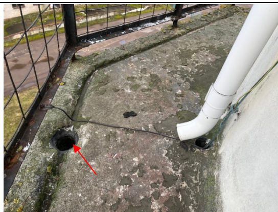
4.20.17.un 4.20.18.att. Platformai R pusē izbūvēta lietusūdeņu noteces vieta.
