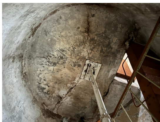
4.6.15.un 4.6.16.att. 5.stāva pārsegums konstatēti būtiski bojājumi, plaisas, izsāļojumi un metāla siju korozija. 5.stāva pārsegums kalpo kā 6.stāva grīda. Mehāniskā stiprība netiek nodrošināta.
