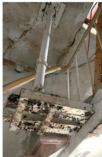
4.6.21.un 4.6.22.att. 4.stāva pārsegumā iespīlēta metāla sliežu konstrukcija.
