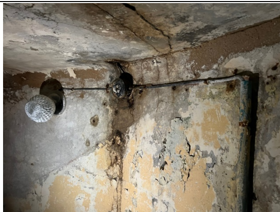
5.9.1.un 5.9.2.att. Apsekotajā ēkā bojāti, neatbilstoši, novecojuši alumīnija elektrības vadi un apgaismojuma elementi.
