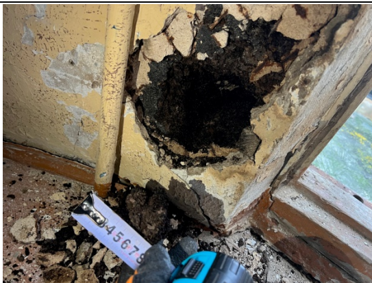
4.2.29.att. Sienai izbūvēta ~7cm bieza izolācija ( korķozola mizas berums vai kūdras plāksnes ).
