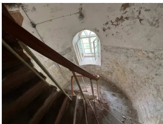
4.2.25.un 4.2.26.att. Torņa ailu pārsedze izbūvēta no ķieģeļu arkveida mūrējuma ar kaļķa javas saistvielu, bez redzamām bojājumu un deformācijas pazīmēm.
