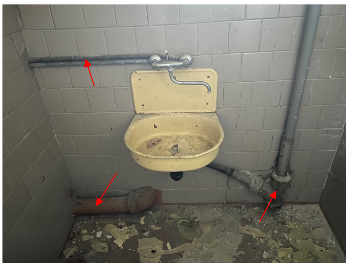
5.1.1.un 5.1.2.att. Aukstā ūdens cauruļvadi un vecie čuguna cauruļvadi ir tehniski nolietotojušies.
