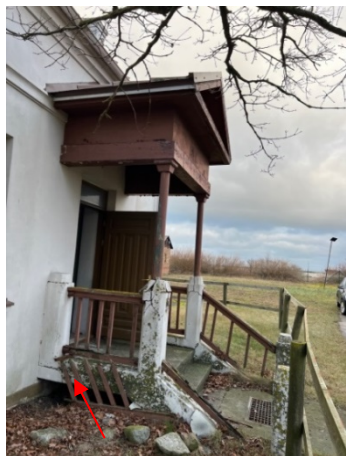
4.9.2.un 4.9.3.att. Betona konstrukcijas lievenis ar diviem pakāpieniem būtiski bojāts. Konstatētas deformācijas plaisas, pārlūzumi, deformācija.
