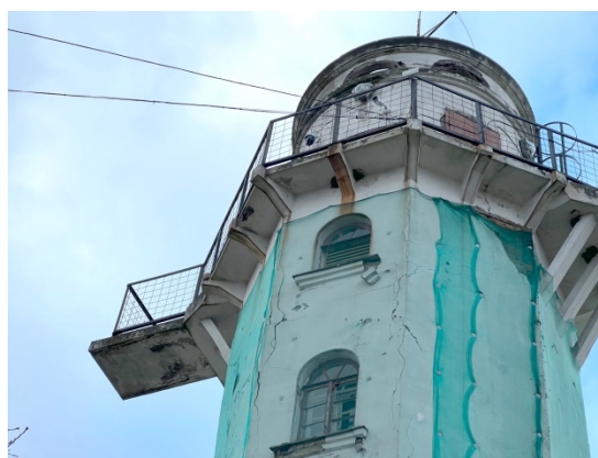
4.2.25.un 4.2.26.att. Torņa ailu pārsedze izbūvēta no ķieģeļu arkveida mūrējuma ar kaļķa javas saistvielu, bez redzamām bojājumu un deformācijas pazīmēm.
