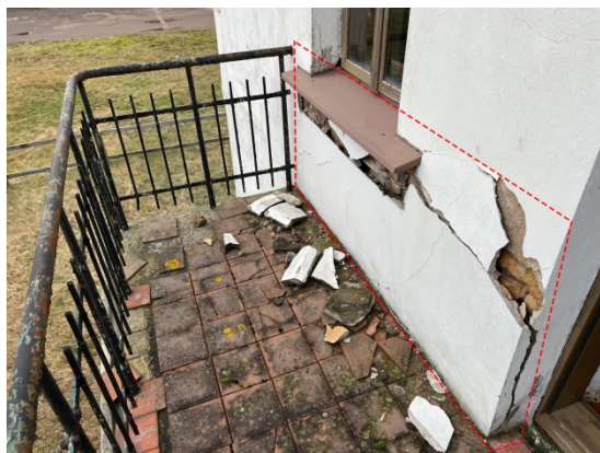
4.2.7.un 4.2.8.att. D pusē otrā stāva līmenī virs balkona konstatēts būtisks apdares bojājums. Atmaosfēras nokrišņu, t.i, mitruma un sala, ietekmē apdares slānis atdalījies no nesošā mūra, atsedzot mūri.
