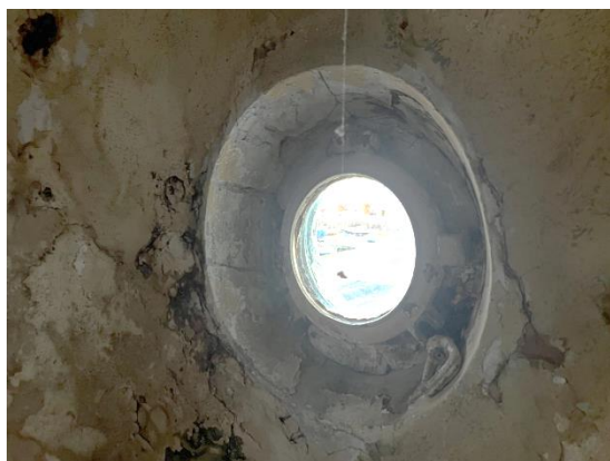
4.13.4.un 4.13.5.att. Torņa 2.un 6.stāvos izbūvēti apaļas formas ar masīvām skrūvēm aizskrūvējami apaļi kuģa (iluminatora tipa) logi. Sestā stāva logiem fasādē izbūvēti arkveida betona uzjumteņi. Logu tehniskais stāvoklis neapmierinošs.
