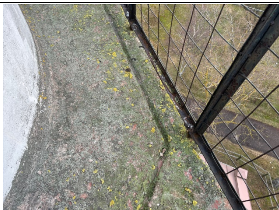
4.20.17.un 4.20.18.att. Platformai R pusē izbūvēta lietusūdeņu noteces vieta.
