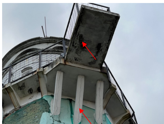
4.20.13.un 4.20.14.att. R pusē izbūvēta lietusūdens notekcaurule. D puses platformas pagarinājumam konstatēti izdrupumi un tērauda siju, stiegrojuma korozija. Atgāžņiem konstatētas plaisas apbetonējumam.
