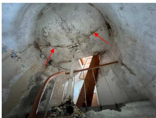
4.6.15.un 4.6.16.att. 5.stāva pārsegums konstatēti būtiski bojājumi, plaisas, izsāļojumi un metāla siju korozija. 5.stāva pārsegums kalpo kā 6.stāva grīda. Mehāniskā stiprība netiek nodrošināta.
