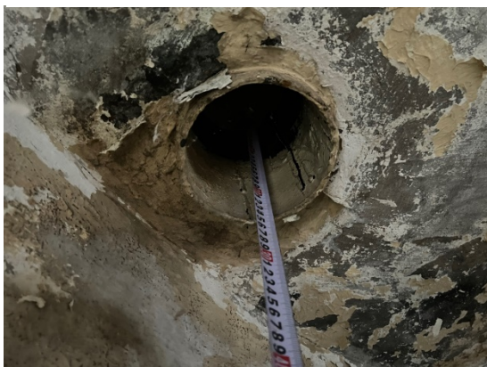
4.8.14.un 4.8.15.att. Dzelzsbetona plātnes biezums ~25cm. Vietām konstatēta mitruma caursūkšanās, izsāļojumi.
