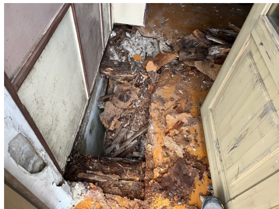
4.6.5.un 4.6.6.att. Siju solis ~1,05m. Sijām konstatēta būtiska trupe, puve siju galos, bojājumu apmērs ~2m no starpsienas. Pārseguma sijas bojājumu vietā nebalstās uz mura, pārseguma konstrukcija avārijas stāvoklī.
