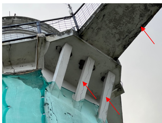
4.20.8.un 4.20.9.att. Z puses platformas pagarinājums, konstatēta tēraudu siju korozija, betona atslāņošanas, izdrupumi un plaisas atgāžņu apbetonējumam.
