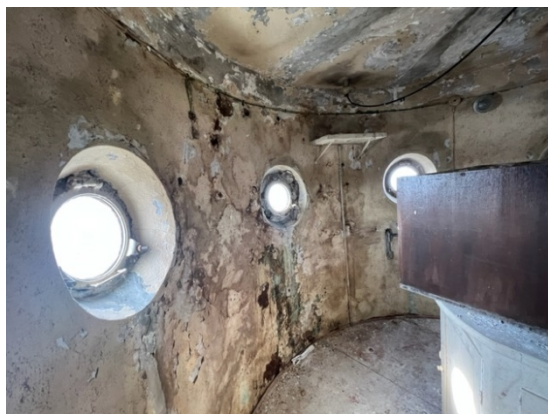
4.2.27.un 4.2.28.att. Torņa 6.st. nesošās sienas izbūvētas cilindra formā no dzelzsbetona konstrukcijas. Caur neblīviem savienojumiem telpā iekļūst mitrums un tiek bojāta iekšējā apdare.
