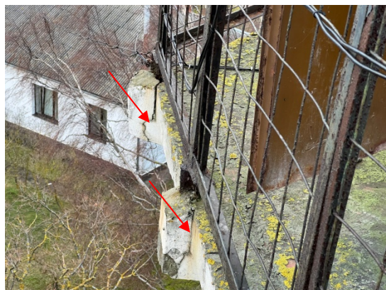
4.20.21.un 4.20.22.att. Lokāli konstatēti bojājumi, plaias stiprības ribu konstrukcijā, kur stiprināti metāla margu stabiņi.
