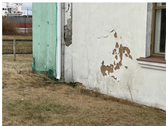
4.2.5.un 4.2.6.att. Ēkas ārējā apdare izbūvēta no cementa / kaļķa javas apmetuma, lokāli konstatēti izdrupumi un sīkplaisas.
