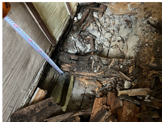
4.6.3.un 4.6.4.att. Pie balkona durvīm tika veikta pārsegums konstrukciju atsegšana, kur konstatēts, ka sijas izbūvētas ar šķērsgriezuma izmēriem ~15x15cm, ~12x20cm, izolācija – cementa un kaļķa sajaukums.
