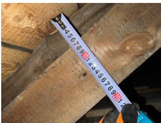
4.8.4.un 4.8.5.att. Spāres izbūvētas ar šķērsriezuma izmēriem ~18x7cm, solis ~1m.
