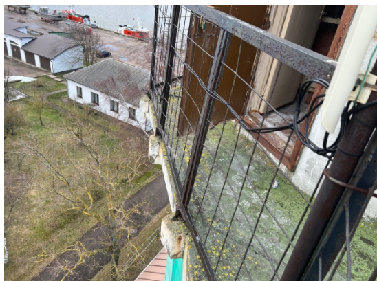
4.20.21.un 4.20.22.att. Lokāli konstatēti bojājumi, plaias stiprības ribu konstrukcijā, kur stiprināti metāla margu stabiņi.
