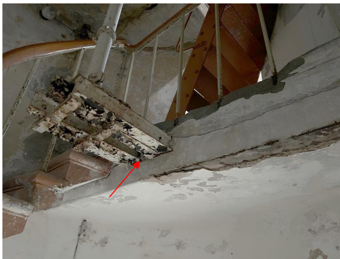
4.6.21.un 4.6.22.att. 4.stāva pārsegumā iespīlēta metāla sliežu konstrukcija.
