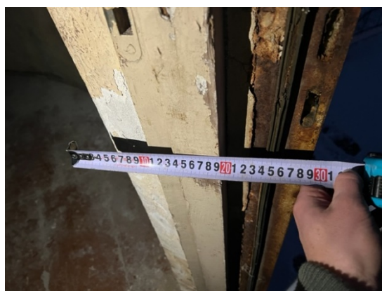
4.2.21.un 4.2.22.att. Torņa ķieģeļu mūra sienas biezums ~95cm, dzlezsbetona konstrukcijas biezums ~30cm ar izolācijas un apdares slāni.
