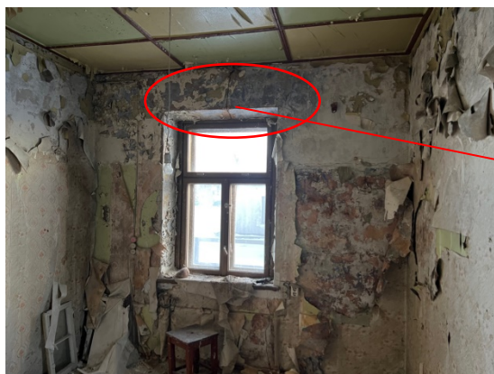
4.2.11.un 4.2.12.att. D pusē konstatētā plaisa no iekšpuses līdz ~3mm plata.
