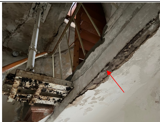
4.6.13.un 4.6.14.att. 4.stāva pārsegumam konstatēti betona bojājumi, izdrupumi, atsegta metāla dubult T sija ar šķērssgriezuma izmēriem ~14,5x10cm. Sijai konstatēta korozija.
