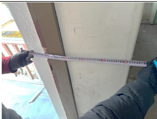
4.2.3.un 4.2.4.att. Ārsienu biezums 1.st. ir ~63cm, 2.st. ~48cm.
