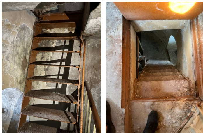
4.10.6.un 4.10.7.att. Pakāpieni stiprināti pie kāpņu vaigiem. Pakāpienu virsmas rievotas. Kāpņu slīpums neatbilst drošas ekspluatācijas nosacījumiem.
