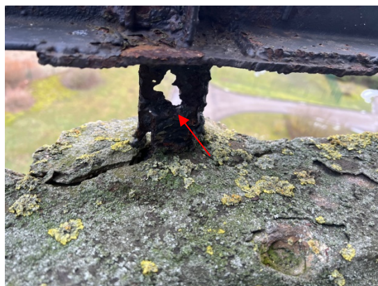
4.20.19.un 4.20.20.att. Platformai izbūvētas metāla konstrukcijas margas. Margu augstums ~1,23m. Margu stabiņiem konstatēta izteikta korozija, bojājumi stiprinājuma vietās.
