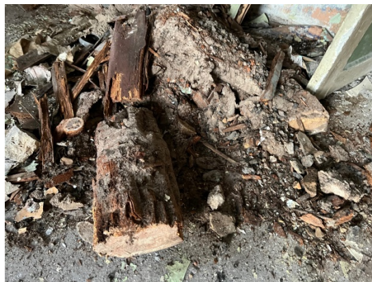
4.12.1.un 4.12.2.att. Pamatu atšurfējuma Nr.4 vietā konstatēta būtiska trupe, puve grīdas koka lāgiem.
