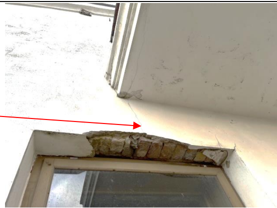
4.2.9.un 4.2.10.att. D pusē konstatēta caurejoša plaisa ailu pārsedzē virs kuras izbūvēts balkons. Balkona noslodze ailu pārsedzes vidus daļā veicinājusi plaisas veidošanos.
