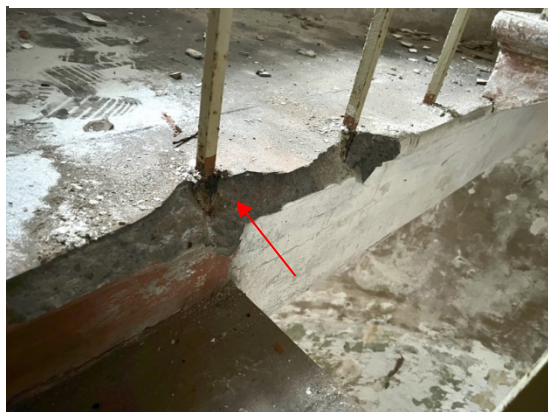
4.6.11.un 4.6.12.att. Pārseguma biezums lokāli ~30 – 35cm. Lokāli konstatēti betona izdrupumi un plaisas margu metāla reliņu stiprinājumu vietās.
