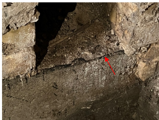
4.1.9.un 4.1.10.att. Konstatēta horizontālā hidroizolācija no 2 kārtām ruberoīda bitumena mastikā. Vertikālā hidroizolācija nav izbūvēta.
