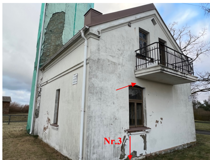
4.1.15.att. Atšurfējums Nr.3 tika veikts zem bojātās ailu pārsedzes.
