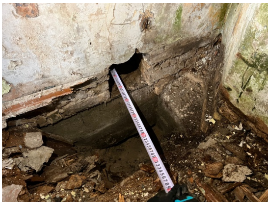
4.12.1.un 4.12.2.att. Pamatu atšurfējuma Nr.4 vietā konstatēta būtiska trupe, puve grīdas koka lāgiem.
