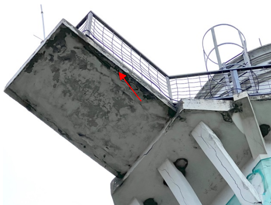
4.20.10.un 4.20.11.att. Z pusē lokāli konstatēti bojājumi, betonējuma izdrupumi.
