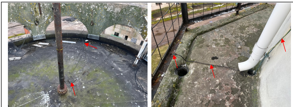
6.6.2.un 6.6.3.att. Zemējuma lenta stiprināta pie metāla margām.
