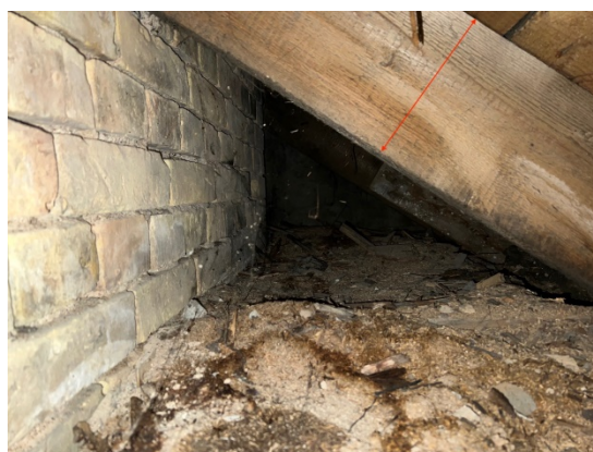
4.8.4.un 4.8.5.att. Spāres izbūvētas ar šķērsriezuma izmēriem ~18x7cm, solis ~1m.
