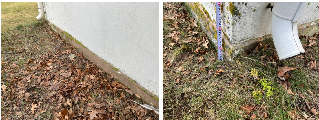
4.1.2.un 4.1.3.att. Virspamatu augstums A, D pusēs ~10 – 15cm.
