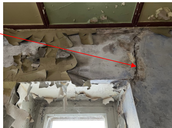
4.2.13.un 4.2.14.att. Ēkas R pusē arī konstatēta caurejoša deformācijas plaisa ailu pārsedzē.
