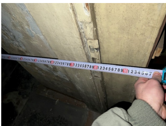
4.2.21.un 4.2.22.att. Torņa ķieģeļu mūra sienas biezums ~95cm, dzlezsbetona konstrukcijas biezums ~30cm ar izolācijas un apdares slāni.
