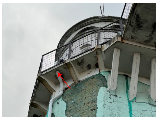
4.20.13.un 4.20.14.att. R pusē izbūvēta lietusūdens notekcaurule. D puses platformas pagarinājumam konstatēti izdrupumi un tērauda siju, stiegrojuma korozija. Atgāžņiem konstatētas plaisas apbetonējumam.
