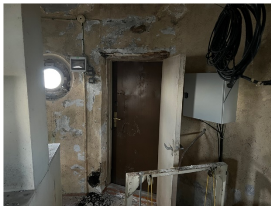
4.2.27.un 4.2.28.att. Torņa 6.st. nesošās sienas izbūvētas cilindra formā no dzelzsbetona konstrukcijas. Caur neblīviem savienojumiem telpā iekļūst mitrums un tiek bojāta iekšējā apdare.
