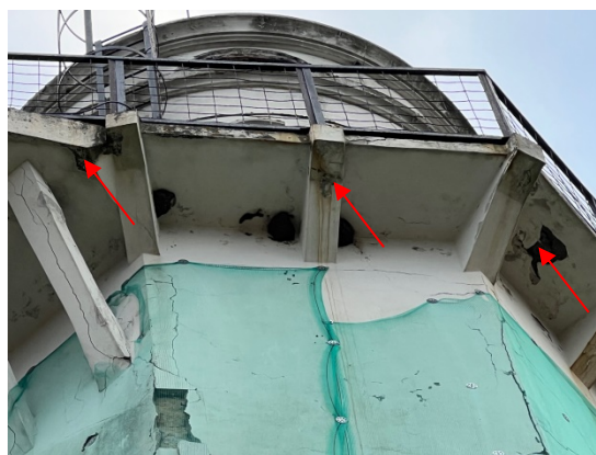
4.20.10.un 4.20.11.att. Z pusē lokāli konstatēti bojājumi, betonējuma izdrupumi.
