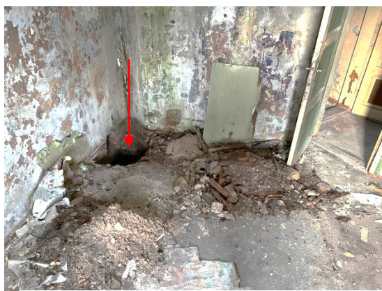
4.1.20.un 4.1.21.att. Atšurfējums Nr.4 tika veikts ēkas iekšpusē vietā kur administratīvajai ēkas daļai pieslēdzas torņa daļa.
