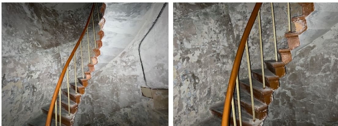
4.10.3.un 4.10.4.att. Margas izbūvētas ar vienkāršiem metāla reliņiem un noapaļotu koka lenteri.
