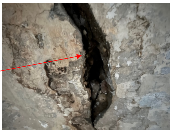
4.6.17.un 4.6.18.att. 5.st. pārsegumam konstatētas būtiskas plaisas visā garumā.
