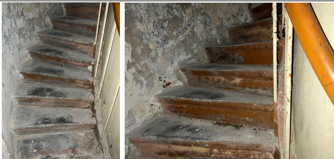
4.10.1.un 4.10.2.att. Tornī izbūvētas spirālveida kāpnes ar betona pakāpieniem, kas konsoļveidīgi iemūrēti ārsienā.
