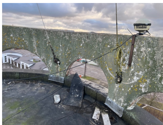
4.2.30.un 4.2.31.att. Virs torņa jumta konstrukcijas izbūvēts nesošās sienas pagarinājums – parapets ar dekoratīvu arkādi. Arkādes pamatnē izbūvēta tērauda loksne, savukārt parapeta konstrukcija izbūvēta no betona konstrukcijas.
