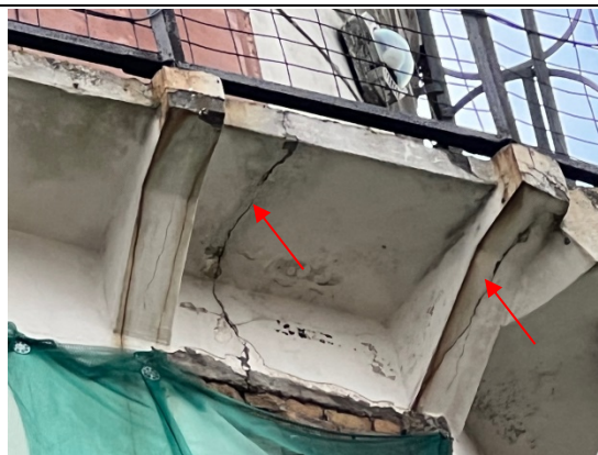
4.20.6.un 4.20.7.att. Pie torņa durvīm konstatēta caurejoša plaisa platformas ~15cm biezajā daļā. Kā arī lokāli konstatētas plaisas bojājumi stiprības ribu apbetonējumam.
