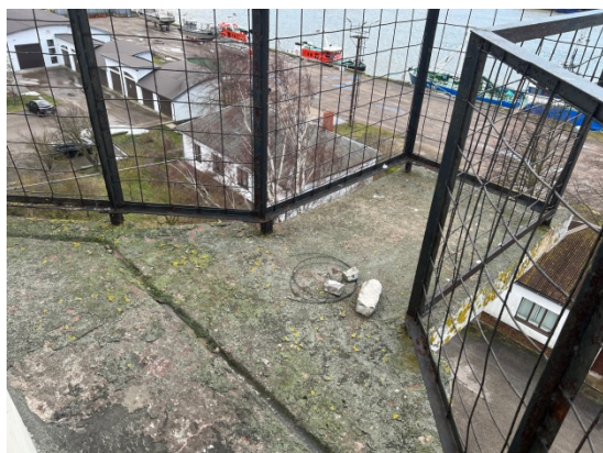
4.20.19.un 4.20.20.att. Platformai izbūvētas metāla konstrukcijas margas. Margu augstums ~1,23m. Margu stabiņiem konstatēta izteikta korozija, bojājumi stiprinājuma vietās.
