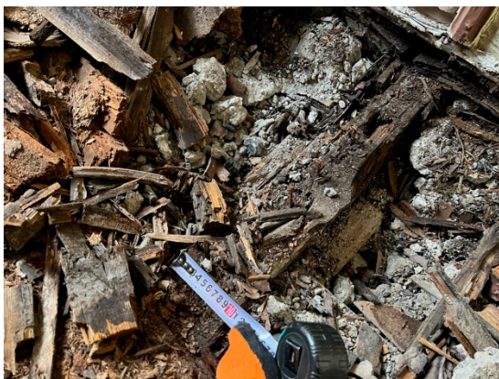
4.6.3.un 4.6.4.att. Pie balkona durvīm tika veikta pārsegums konstrukciju atsegšana, kur konstatēts, ka sijas izbūvētas ar šķērsgriezuma izmēriem ~15x15cm, ~12x20cm, izolācija – cementa un kaļķa sajaukums.
