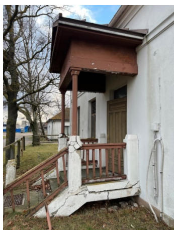
4.9.4.un 4.9.5.att. Deformācijas plaisas, bojājumi, lieveņa konstrukcija pirmsavārijas stāvoklī.
