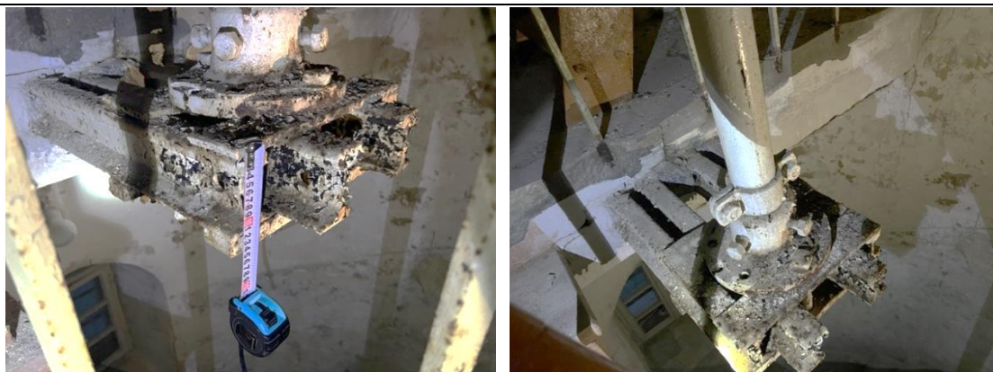
4.6.23.un 4.6.24.att. Metāla sliežu augstums ~10cm. Metāla sliežu konstrukcija kalpo kā pamats torņa centrā izbūvētajai caurulei/balstam.
