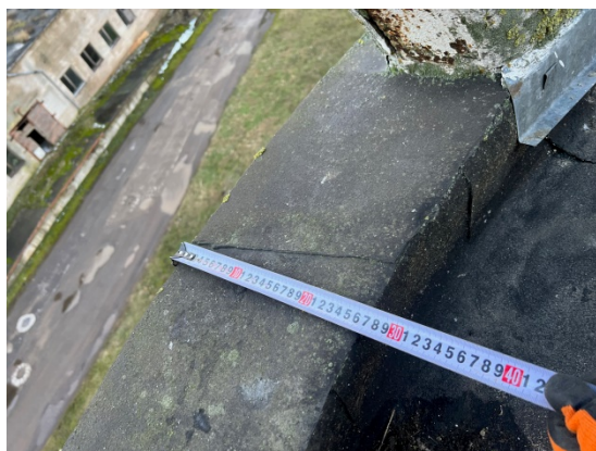
4.2.32.un 4.2.33.att. Parapeta biezums apakšdaļā ~26cm, augšdaļā kur izbūvēta dekoratīva josla ~38cm.
