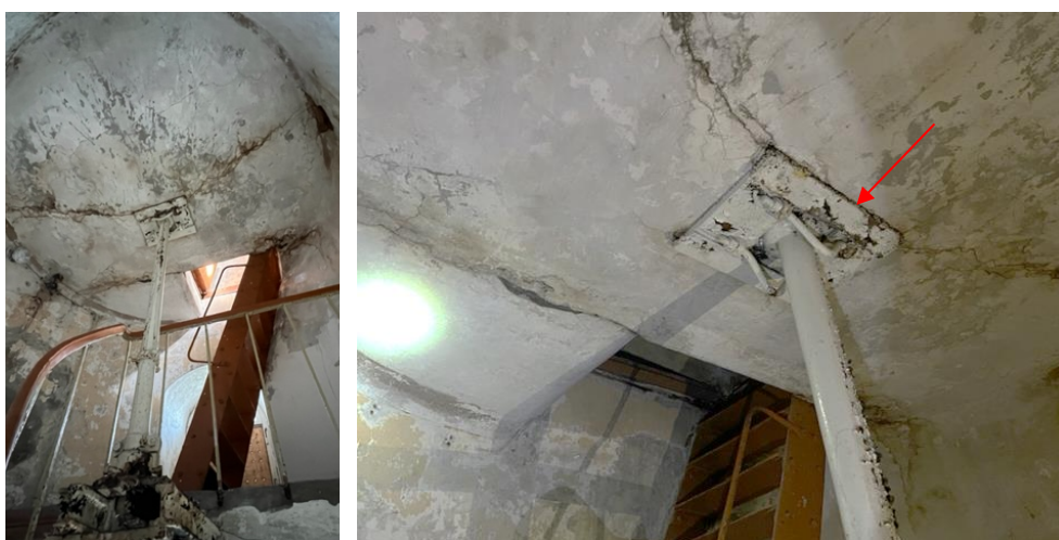
4.6.25.un 4.6.26.att. Centrālā caurule/balsts izbūvēta cauri un sasaitīta ar 5.stāva pārsegumu un 6.stāva pārsegumu jeb torņa dzelzsbetona jumta pārseguma konstrukciju.
