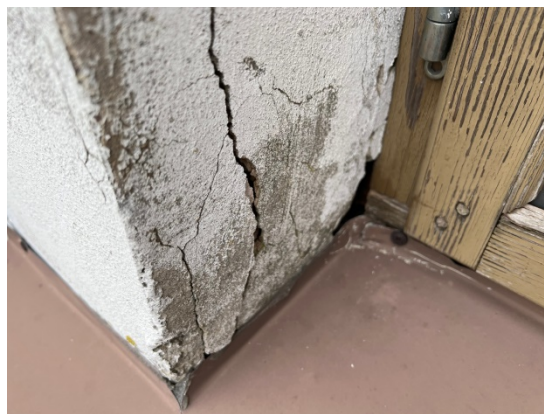
4.2.7.un 4.2.8.att. D pusē otrā stāva līmenī virs balkona konstatēts būtisks apdares bojājums. Atmaosfēras nokrišņu, t.i, mitruma un sala, ietekmē apdares slānis atdalījies no nesošā mūra, atsedzot mūri.
