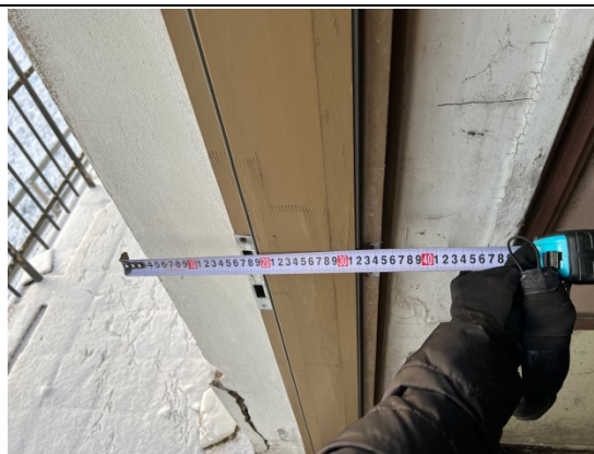
4.2.3.un 4.2.4.att. Ārsienu biezums 1.st. ir ~63cm, 2.st. ~48cm.
