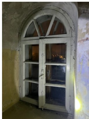
4.13.2.un 4.13.3.att. Torņa koka konstrukcijas logi ar arkveida spraišļotiem virslogiem, lokāli konstatēti bojājumi.
