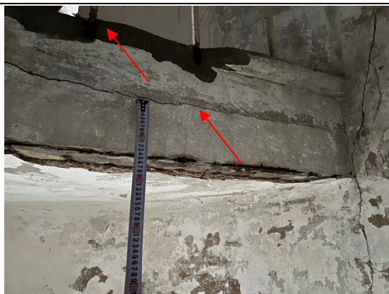
4.6.13.un 4.6.14.att. 4.stāva pārsegumam konstatēti betona bojājumi, izdrupumi, atsegta metāla dubult T sija ar šķērssgriezuma izmēriem ~14,5x10cm. Sijai konstatēta korozija.
