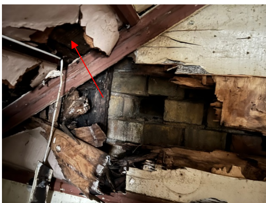
4.8.2.un 4.8.3.att. Uz nesošām ārsienām izbūvētas koka konstrukcijas. Ēkas ZR pusē pie torņa sienas konstatēti izteiktākie jumta koka konstrukciju bojājumi.
