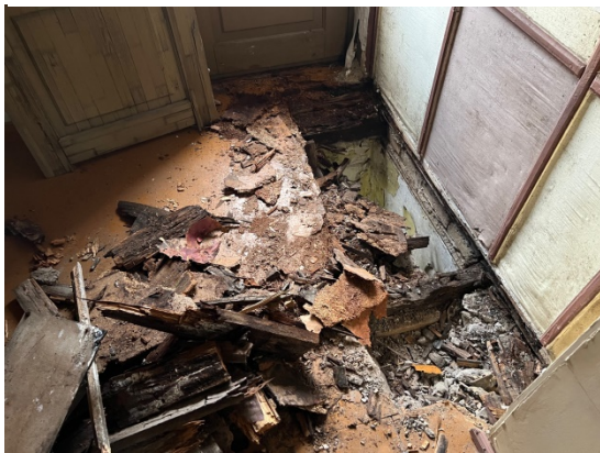
4.6.5.un 4.6.6.att. Siju solis ~1,05m. Sijām konstatēta būtiska trupe, puve siju galos, bojājumu apmērs ~2m no starpsienas. Pārseguma sijas bojājumu vietā nebalstās uz mura, pārseguma konstrukcija avārijas stāvoklī.
