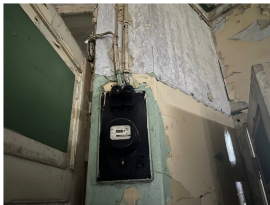
5.9.4.un 5.9.5.att. Vietām izbūvētas jaunas sadalošās elektroietaisies, taču lokāli saglabājušās vecās elektroietaisies.
