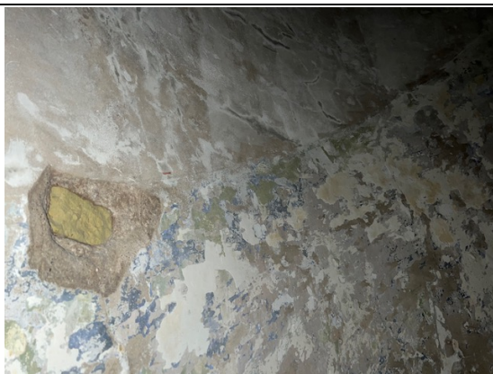
4.2.23.un 4.2.24.att. Torņa sienām iekšējā apdare izbūvēta no kaļķa javas apmetuma.
