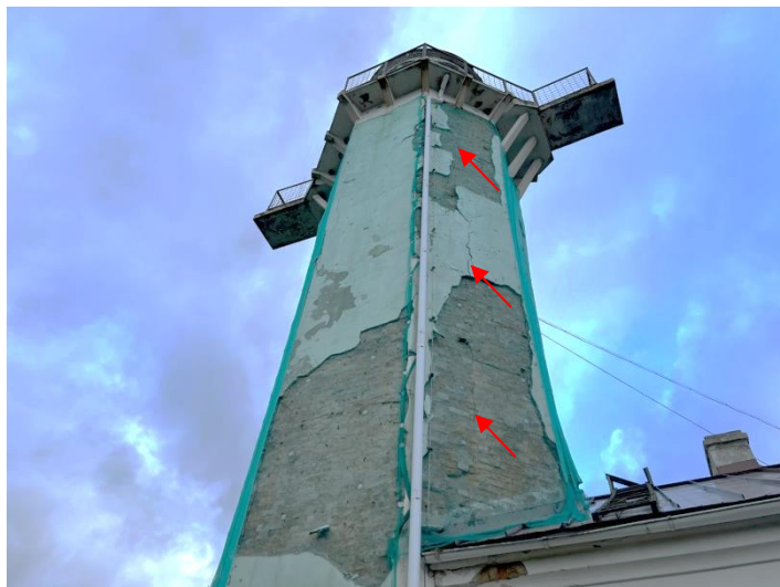
4.2.16.att. Būtiskākie apdares bojājumi ir DR, R pusēs. Kā arī DR pusē konstatēta plaisa mūrī, taču no iekšpuses plaisa netka konstatēta.
