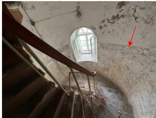
4.18.7.un 4.18.8.att. Torņa sienām izbūvēta kaļķa javas apdare. Paralēli kāpnēm siena agrāk rotāta ar melnu svītru, kas šobrīd viegli saskatāma.
