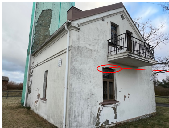
4.2.9.un 4.2.10.att. D pusē konstatēta caurejoša plaisa ailu pārsedzē virs kuras izbūvēts balkons. Balkona noslodze ailu pārsedzes vidus daļā veicinājusi plaisas veidošanos.
