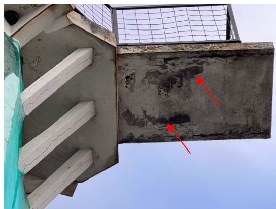
4.20.15.un 4.20.16.att. Bojājumi D puses platformas pagarinājuma konstrukcijā. Metāla sijām konstatēta korozija.
