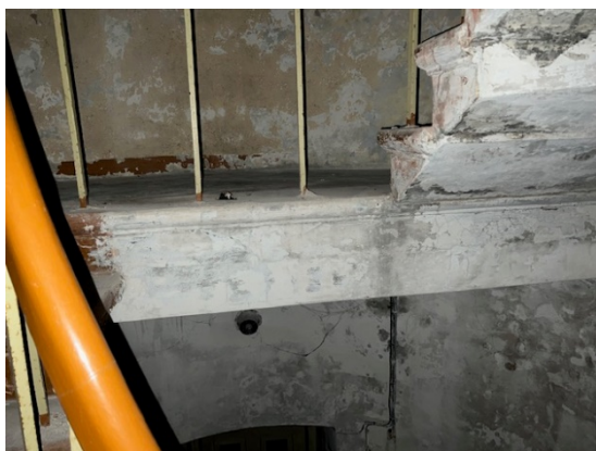
4.6.9.un 4.6.10.att. Uz torņa nesošajām ārsienām balstīts un izbūvēts metāla siju pārsegums ar betonējumu (dzelzsbetons), kas kalpo kā kāpņu laukumi.
