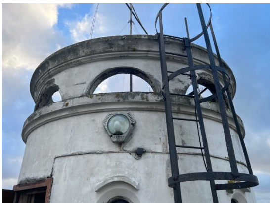
4.8.12.un 4.8.13.att. Uz torņa nesošām ārsienām izbūvēta dzelzsbetona konstrukcija ar nelielu slīpumu no centra uz malām.
