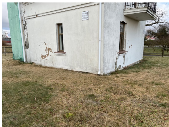
4.2.5.un 4.2.6.att. Ēkas ārējā apdare izbūvēta no cementa / kaļķa javas apmetuma, lokāli konstatēti izdrupumi un sīkplaisas.
