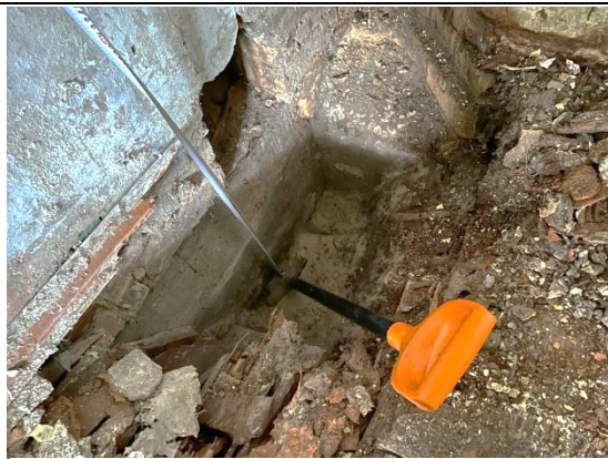
4.1.18.un 4.1.19.att. Atšurfējums Nr.4 tika veikts ēkas iekšpusē vietā kur administratīvajai ēkas daļai pieslēdzas torņa daļa.
