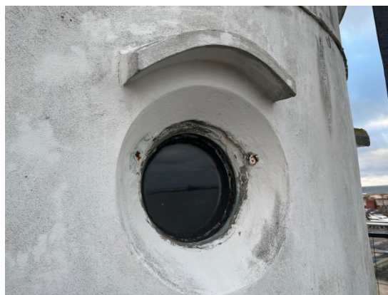
4.13.4.un 4.13.5.att. Torņa 2.un 6.stāvos izbūvēti apaļas formas ar masīvām skrūvēm aizskrūvējami apaļi kuģa (iluminatora tipa) logi. Sestā stāva logiem fasādē izbūvēti arkveida betona uzjumteņi. Logu tehniskais stāvoklis neapmierinošs.
