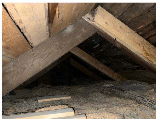
4.8.2.un 4.8.3.att. Uz nesošām ārsienām izbūvētas koka konstrukcijas. Ēkas ZR pusē pie torņa sienas konstatēti izteiktākie jumta koka konstrukciju bojājumi.
