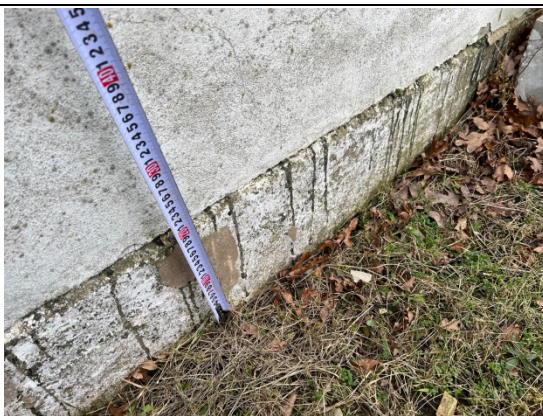
4.1.8.att. Z pusē virspamatu augstums ir ~20cm
