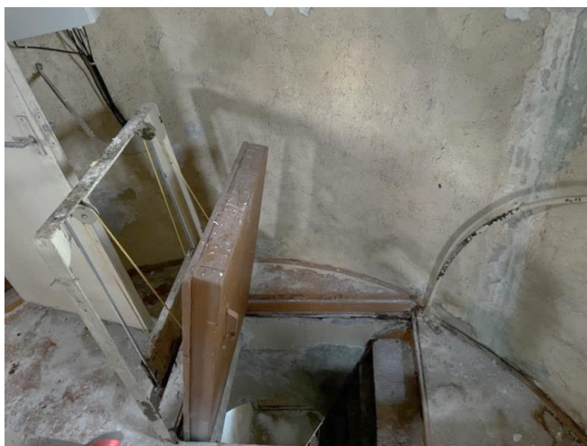
4.13.10.att. Lūkai saglabājies vēsturiskais vērtnes fiksācijas mehānisms, kas ir novecojis un rada bīstamību. Konstatēts fiksācijas mehānisma atslābums.
