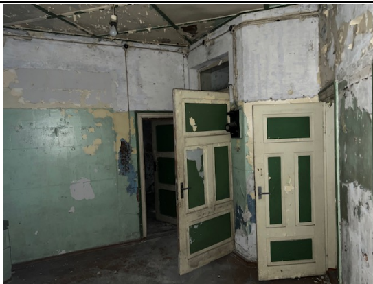
4.13.1.att. Administratīvās ēkas koka konstrukcijas iekšdurvis.
