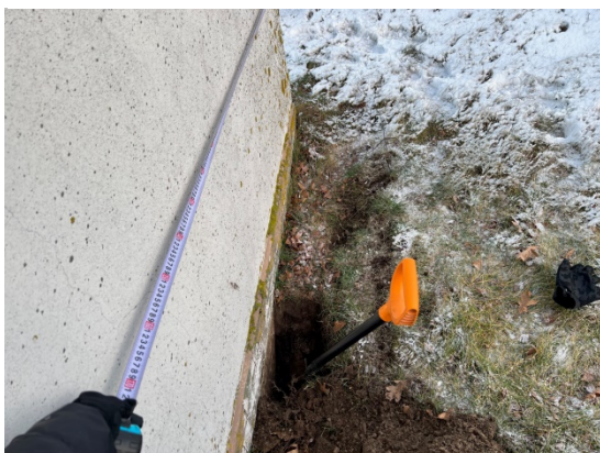
4.1.11.un 4.1.12.att. Atšurfējumā Nr.1 konstatēts, ka lentveida pamatu kopējais augstums ir ~50cm.
