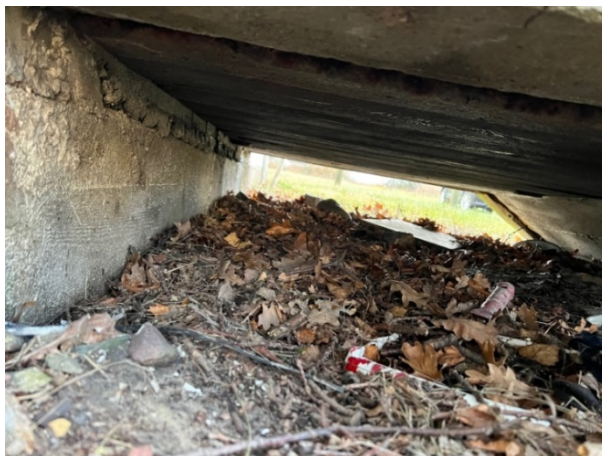
4.9.2.un 4.9.3.att. Betona konstrukcijas lievenis ar diviem pakāpieniem būtiski bojāts. Konstatētas deformācijas plaisas, pārlūzumi, deformācija.
