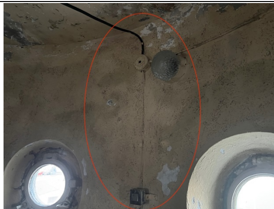
5.9.1.un 5.9.2.att. Apsekotajā ēkā bojāti, neatbilstoši, novecojuši alumīnija elektrības vadi un apgaismojuma elementi.
