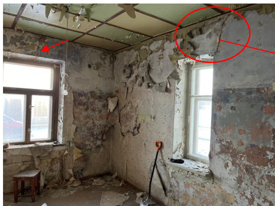
4.2.13.un 4.2.14.att. Ēkas R pusē arī konstatēta caurejoša deformācijas plaisa ailu pārsedzē.
