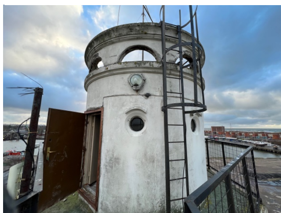
4.2.30.un 4.2.31.att. Virs torņa jumta konstrukcijas izbūvēts nesošās sienas pagarinājums – parapets ar dekoratīvu arkādi. Arkādes pamatnē izbūvēta tērauda loksne, savukārt parapeta konstrukcija izbūvēta no betona konstrukcijas.
