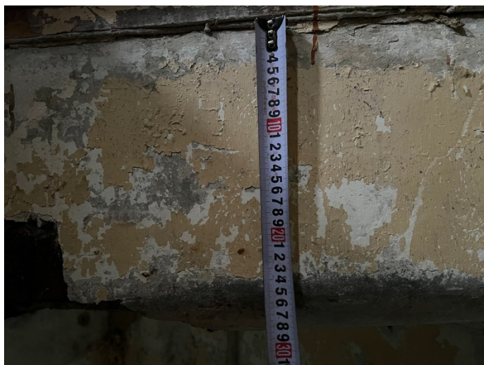
4.6.20.att. 5.st.pārseguma biezums ir ~30cm.
