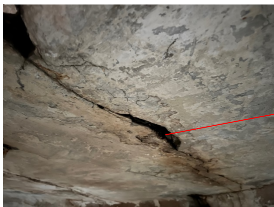
4.6.17.un 4.6.18.att. 5.st. pārsegumam konstatētas būtiskas plaisas visā garumā.
