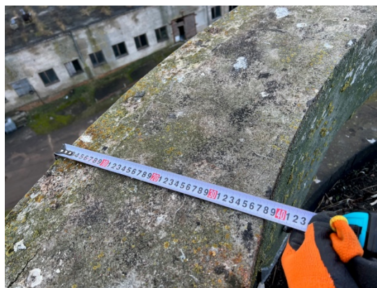
4.2.32.un 4.2.33.att. Parapeta biezums apakšdaļā ~26cm, augšdaļā kur izbūvēta dekoratīva josla ~38cm.
