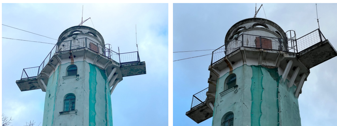
4.20.2.un 4.20.3.att. Torņa 6.stāva līmenī ārpusē izbūvēta apkalpes platforma ar pagarinājumiem Z un D pusēs.
