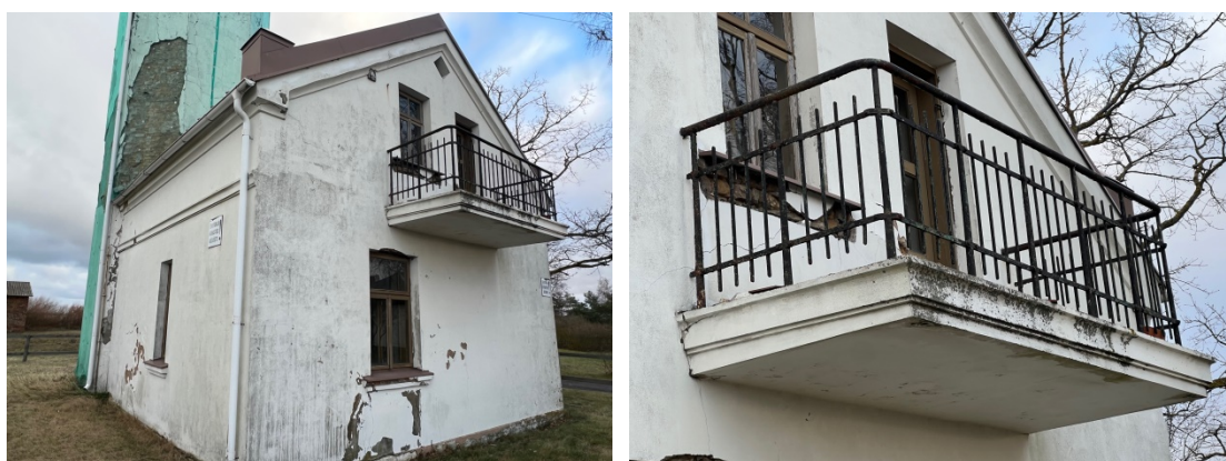
4.9.8.un 4.9.9.att. Administratīvās ēkas D galā izbūvēts dzelzsbetona konstrukcijas balkons, apmierinošā-labā stāvoklī.
