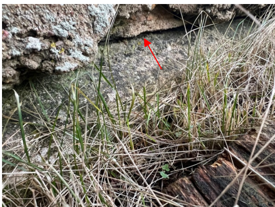
4.1.9.un 4.1.10.att. Konstatēta horizontālā hidroizolācija no 2 kārtām ruberoīda bitumena mastikā. Vertikālā hidroizolācija nav izbūvēta.
