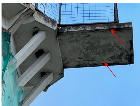
4.20.8.un 4.20.9.att. Z puses platformas pagarinājums, konstatēta tēraudu siju korozija, betona atslāņošanas, izdrupumi un plaisas atgāžņu apbetonējumam.
