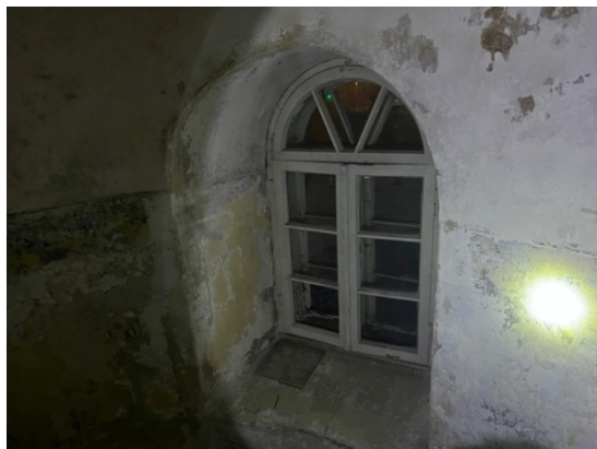
4.13.2.un 4.13.3.att. Torņa koka konstrukcijas logi ar arkveida spraišļotiem virslogiem, lokāli konstatēti bojājumi.
