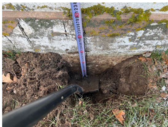
4.1.11.un 4.1.12.att. Atšurfējumā Nr.1 konstatēts, ka lentveida pamatu kopējais augstums ir ~50cm.
