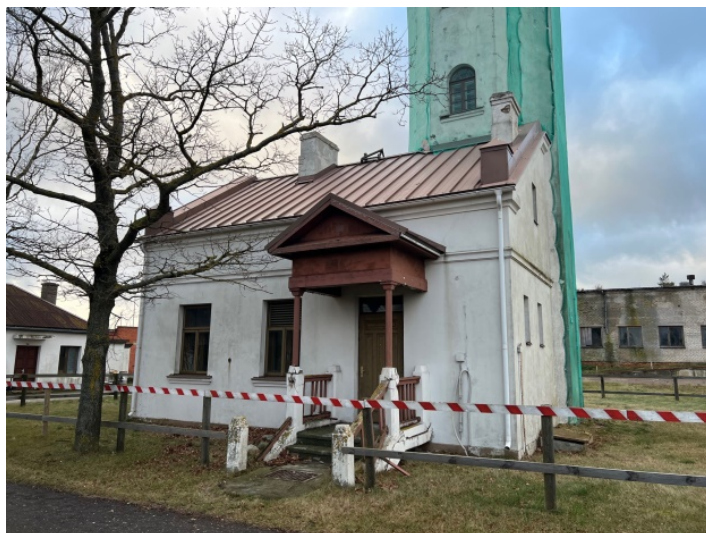
4.2.2.att. Uz ēkas pamatiem izbūvētas dzelteno māla pilnķieģeļu mūra sienas ar kaļķa javas saistvielu. Sienām izbūvēti dekoratīvi izvirzījumi – starpdzega, dzega un palodžu profili. Ēkas galos izbūvēts skārda seguma parapets.
