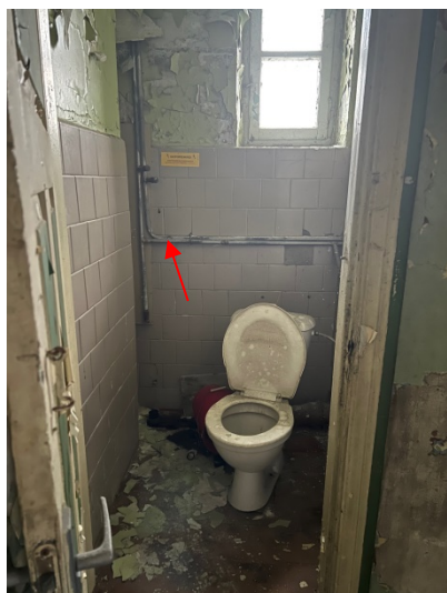
5.1.1.un 5.1.2.att. Aukstā ūdens cauruļvadi un vecie čuguna cauruļvadi ir tehniski nolietotojušies.
