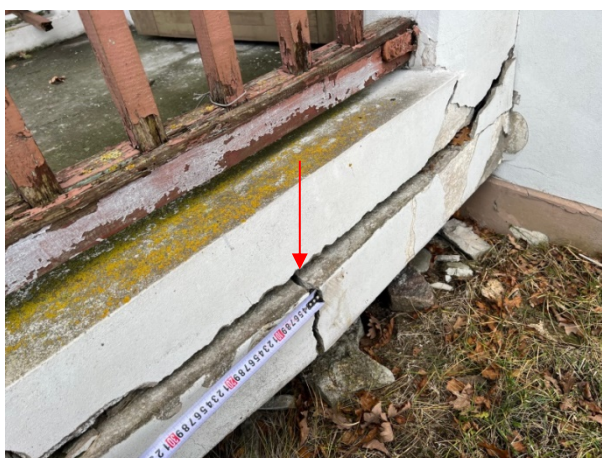
4.9.4.un 4.9.5.att. Deformācijas plaisas, bojājumi, lieveņa konstrukcija pirmsavārijas stāvoklī.
