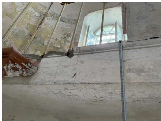
4.6.11.un 4.6.12.att. Pārseguma biezums lokāli ~30 – 35cm. Lokāli konstatēti betona izdrupumi un plaisas margu metāla reliņu stiprinājumu vietās.
