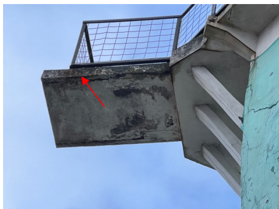
4.20.15.un 4.20.16.att. Bojājumi D puses platformas pagarinājuma konstrukcijā. Metāla sijām konstatēta korozija.
