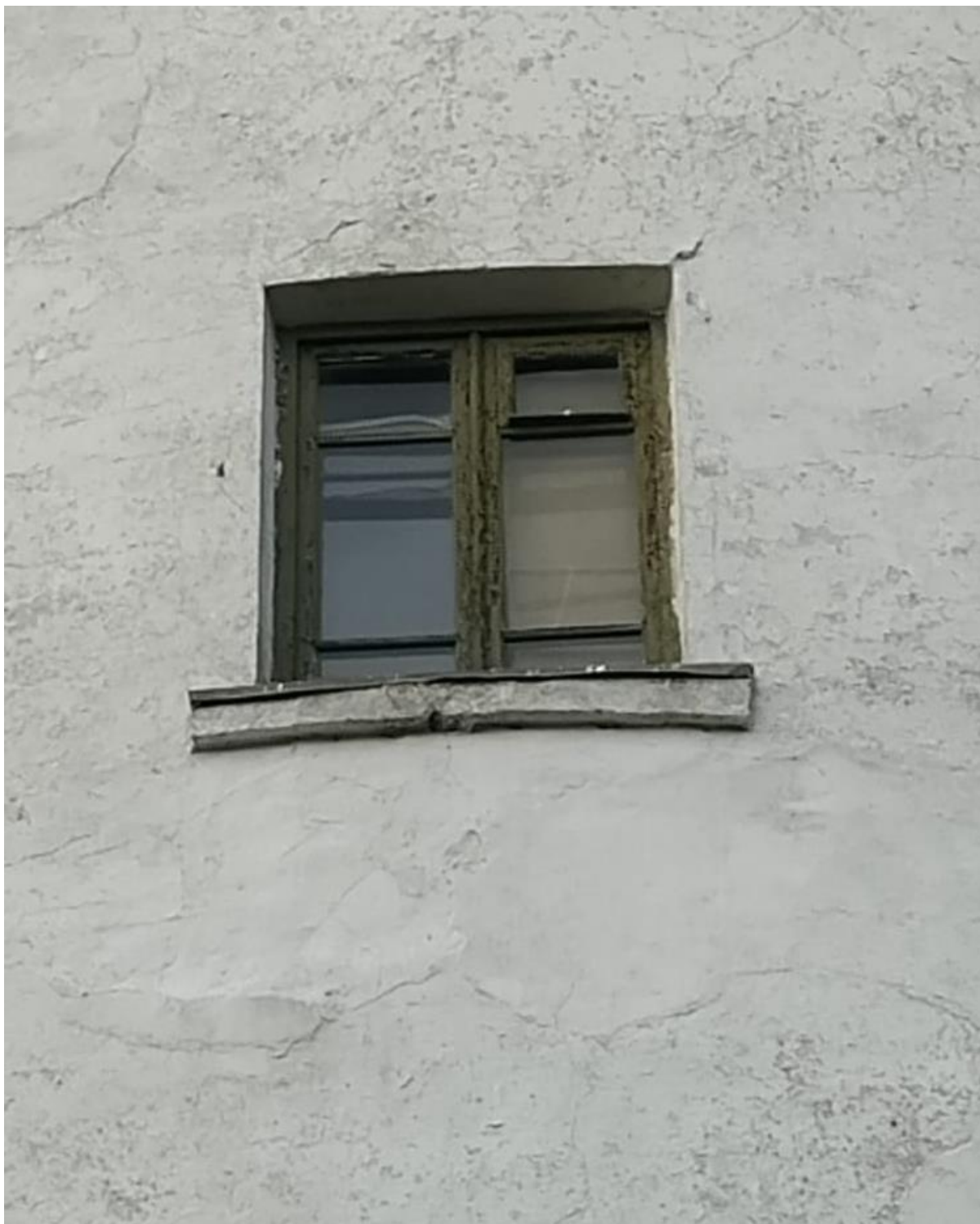
2.att .Bojātais koka logs (austrumu pusē). 4.stāvs
